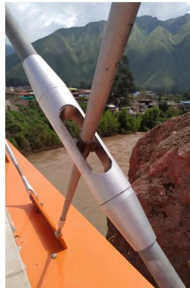
Figura 20. Detalle cruce péndolas con manguito rasgado
