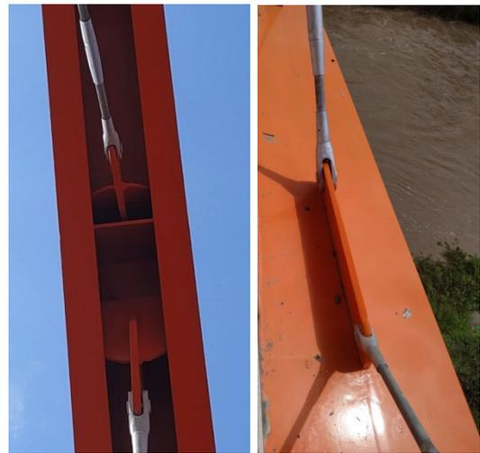
Figura 18. Detalle anclaje de péndola en arco y tablero
