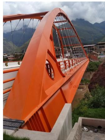
Figura 24. Vista de la viga de borde y el arco
