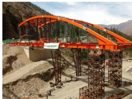
Figura 25. Proceso de construcción por lanzamiento sobre torretas provisionales
