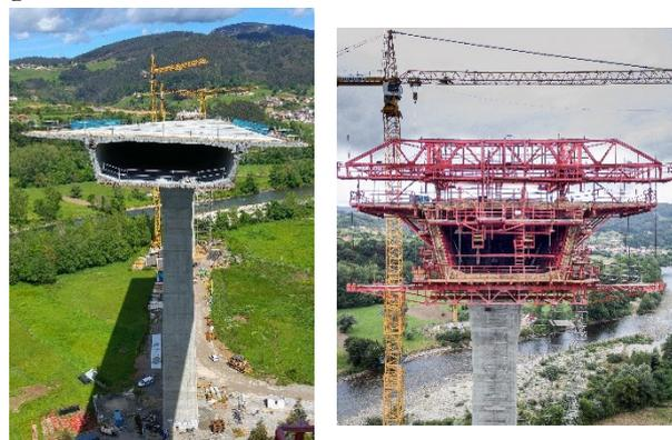
Figura 3 Sección transversal con ancho de 23.20 m sin puntales ni nervios transversales
