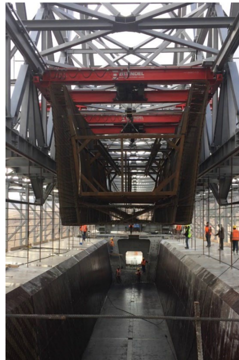
Figura 11. Transporte de un módulo de acero de refuerzo con los puentes grúas del M1-90-S
