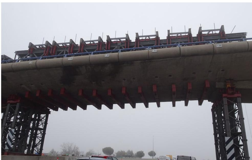
Figura 17. Sistema de cuelgue de las dovelas del vano 5
