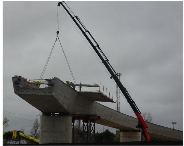
Figura 24. Proceso del montaje de vigas y prelasas del nuevo tablero
