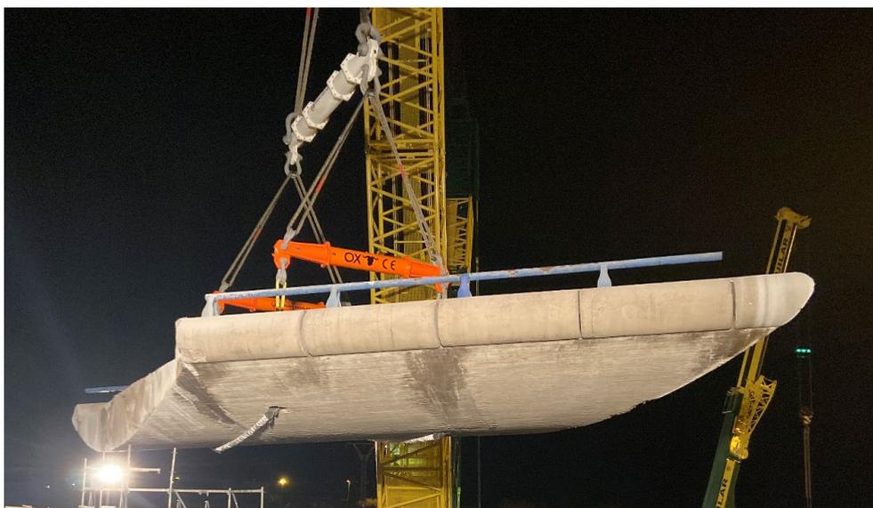
Figura 15. Izado de tramo del tablero
