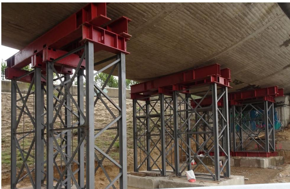
Figura 14. Torres de apoyo empleadas en el desmontaje
