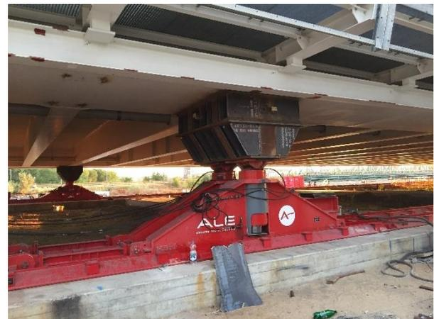
Figura 11. Skidshoe y estructura IST
