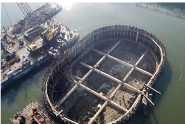
Figura 6. Ejecución de pila central
