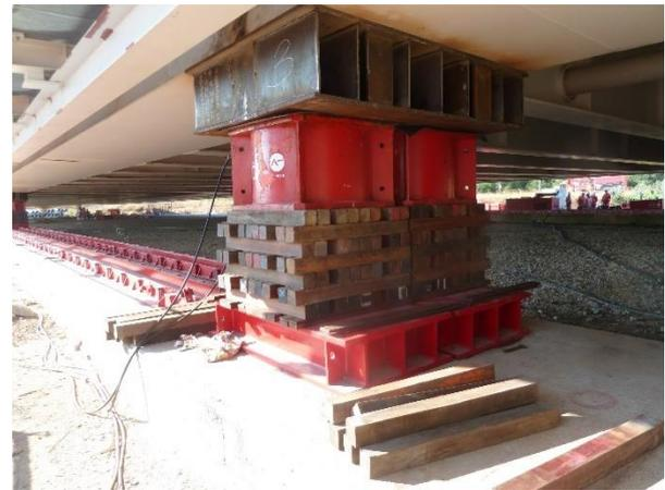
Figura 10. Gatos de levantamiento y estructura IST
