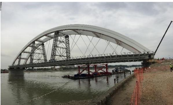
**Figura 21. Retirada de pontona**
