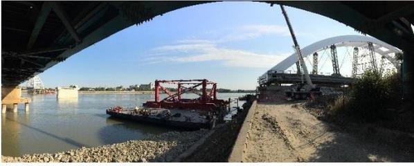
**Figura 13. Pontona y estructura auxiliar**
