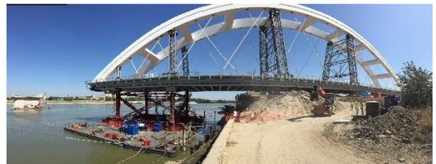
**Figura 16. Transferencia de cargas a pontona**
