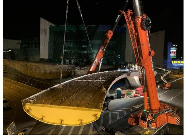
**Figura 15. Colocación de segundo tramo metálico (1)**
