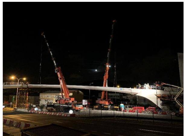
**Figura 16 Colocación de segundo tramo metálico (2)**
