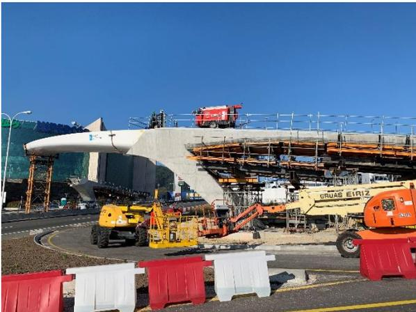
**Figura 14. Colocación de primer tramo metálico (2)**
