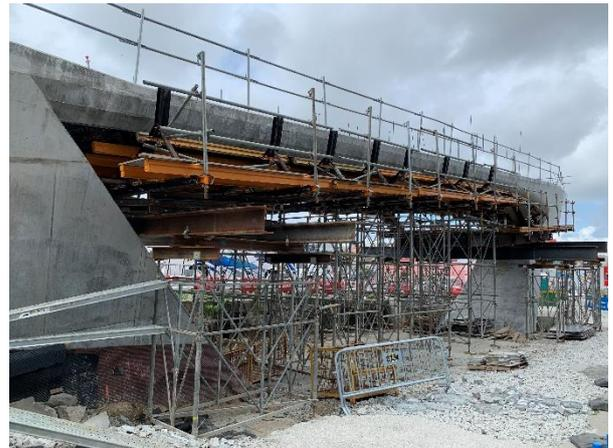
Figura 12. Descimbrado de pila
