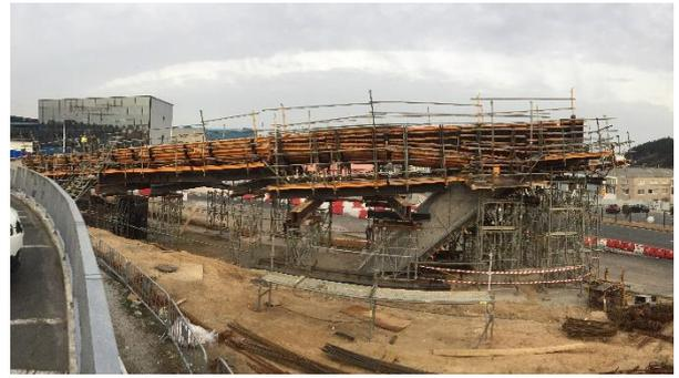
Figura 11. Hormigonado de vano lateral
