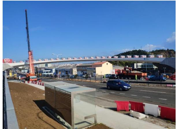
Figura 20. Prueba de carga estática
