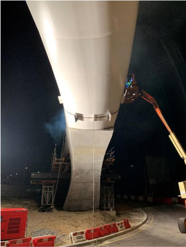
**Figura 13. Colocación de primer tramo metálico (1)**
