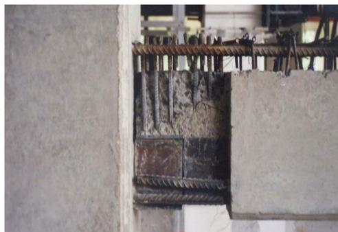
Figura 8. Conexión “seca” con soldadura en placas y varillas [8]
