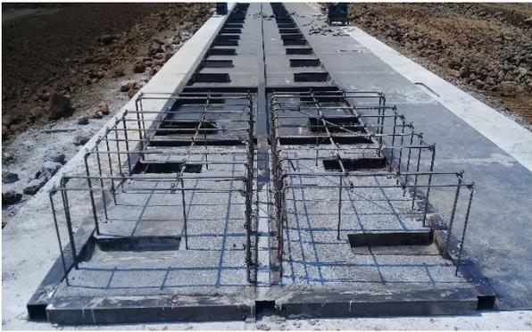
Figura 18 Molde metálicos para colado de vigas prefabricadas sección U
