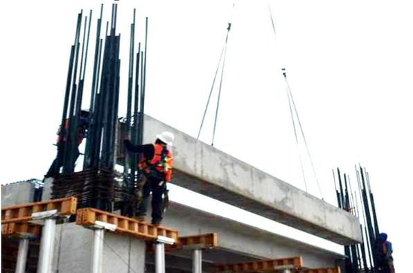
Figura 19 Montaje de viga prefabricada sección U
