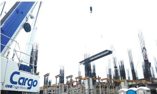
Figura 20 Montaje de losa prefabricada doble T
