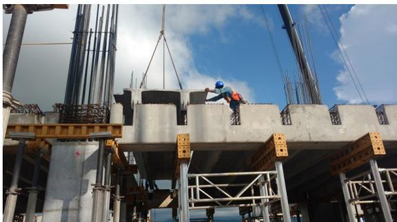
Figura 7. Conexión “húmeda” Hospital de Tepic.
