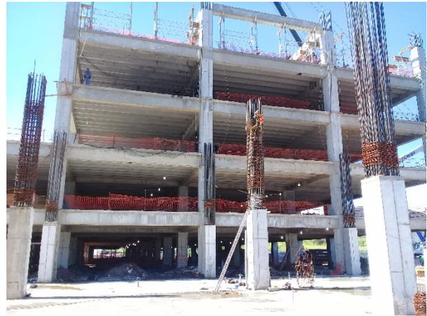
**Figura 5. Cuerpo 1 del edificio en proceso de montaje, cuerpo 2 en proceso de construcción de pilares.**
