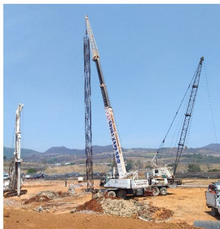
Figura 16. Habilitado de acero de refuerzo en pilas de cimentación, con longitud de 25 m
