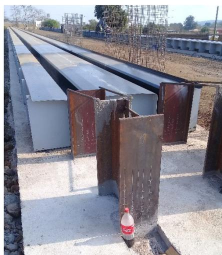
Figura 17. Moldes metálicos para hormigonado de elementos pretensados doble T y cabezal de tensado.
