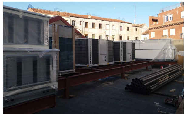
Figura 13. Bancadas metálicas sobre cubierta
