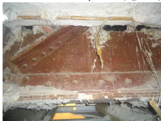
Figura 20. Unión roblonada en cercha principal
