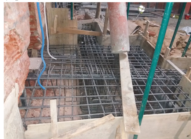
Figura 9. Cimentación excéntrica de pilares nuevos
