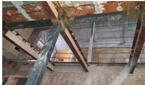
Figura 15. Pilar nuevo y viga de apeo a cortar en el Lobby antes de demolición parcial
