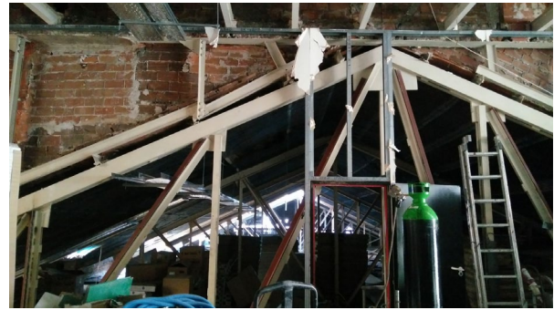
Figura 12. Cercha en cubierta con refuerzos
