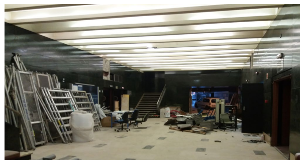
Figura 16. Estado original forjado lobby
