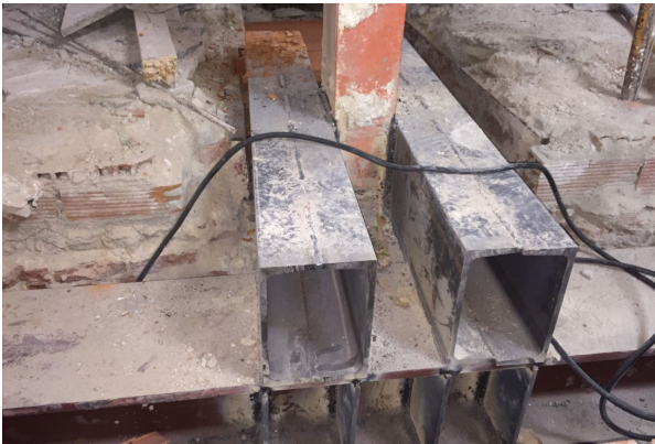
Figura 11. Arranque de pilar existente soldado a vigas del pórtico.
