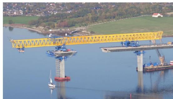
Figura 22. Colocación del lanzador.
