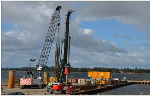
Figura 6. Ejecución pilote on-shore.
