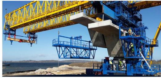
Figura 21. Inicio del montaje "voladizos sucesivos".
