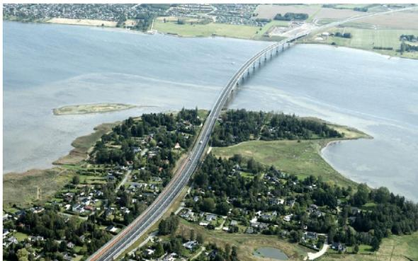
Este puente, - con 15 vanos de 83 metros y 2 vanos en extremos de 57,35 metros-, ha sido construido mediante la técnica de voladizos sucesivos con dovelas prefabricadas, instalados mediante viga de lanzamiento.
