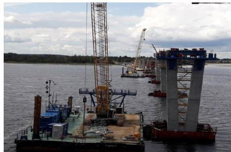
Figura 18. Pilas en “V”.
