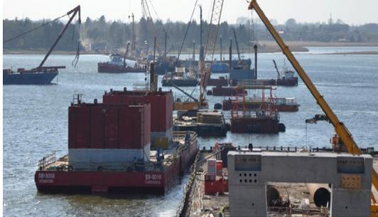
Figura 12. Fabricación del “cofferdam”.
