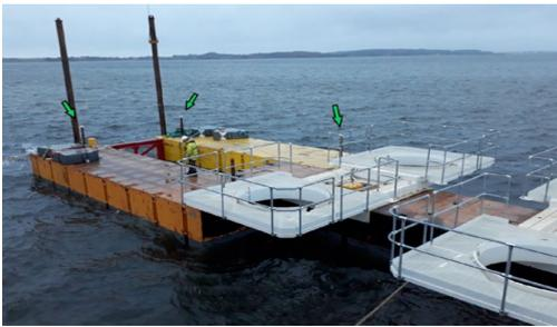
**Figura 9. Plantilla de replanteo. Pilotes.**
