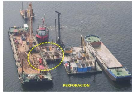
**Figura 10. Perforación de pilotes off-shore.**
