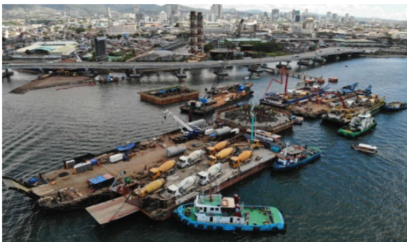
Figura 8. Foto durante el hormigonado del T1.
