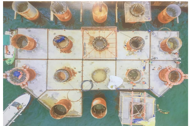
Figura 5. Foto de prelosas prefabricadas.
