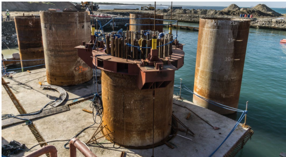
Figura 6. Esquema del sistema provisional de cuelgue con la prelosa en posición.
