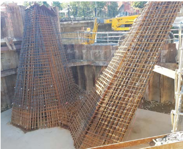
Figura 9. Ferralla alrededor del bastidor metálico de pila
