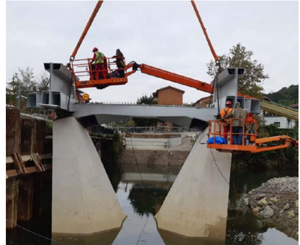
Figura 11. Colocación de nudo en pila
