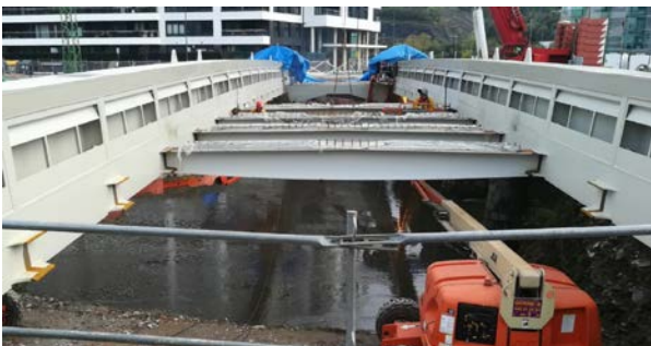
Figura 14. Soldadura de costillas transversales
