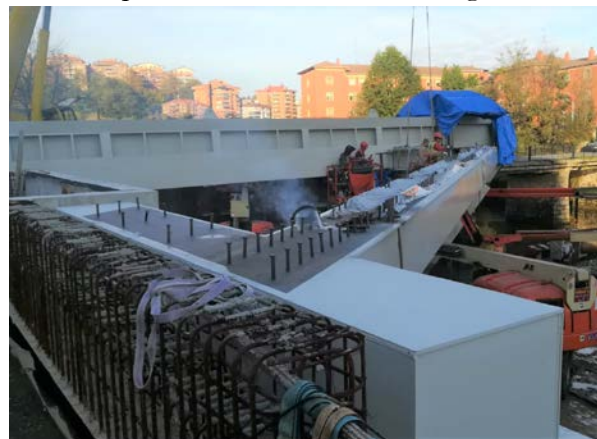
Figura 15. Colocación de pasarela aguas arriba
