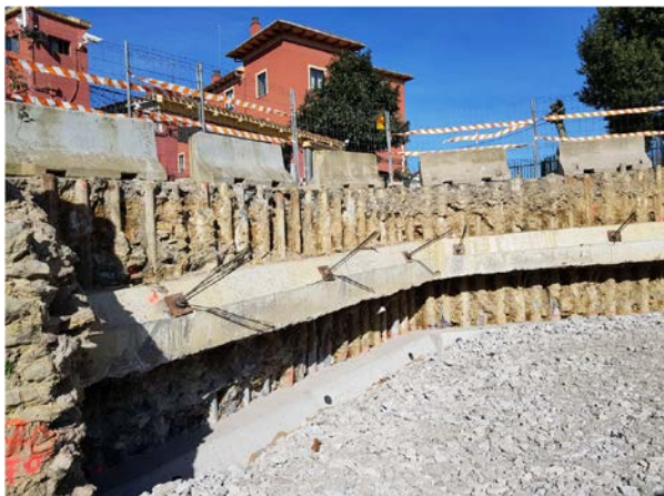
Figura 7. Pantalla de micropilotes en Estribo 2
