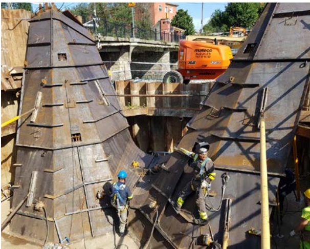
Figura 10. Encofrado de pila
