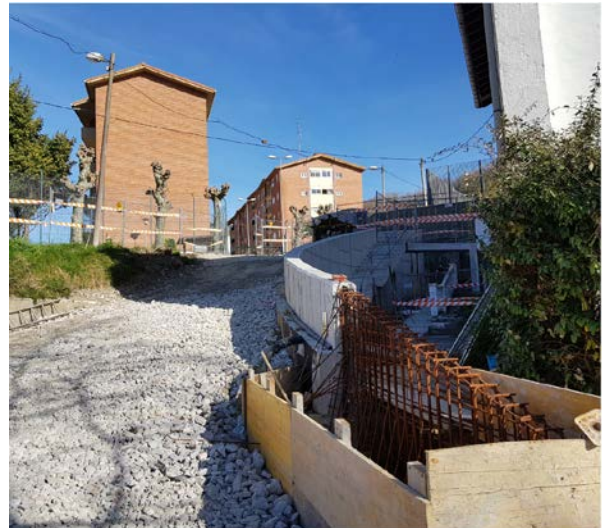
Figura 8. Muro en rampa del caserío
