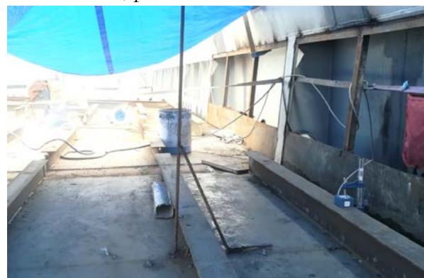
Figura 17. Acelerómetros en fase de construcción
