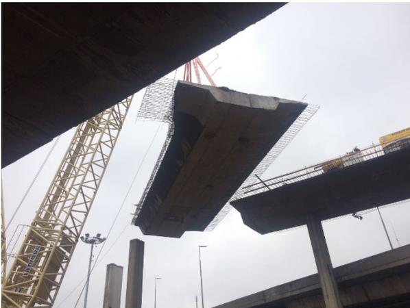
Figura 7. Demolición Ramal Existente
