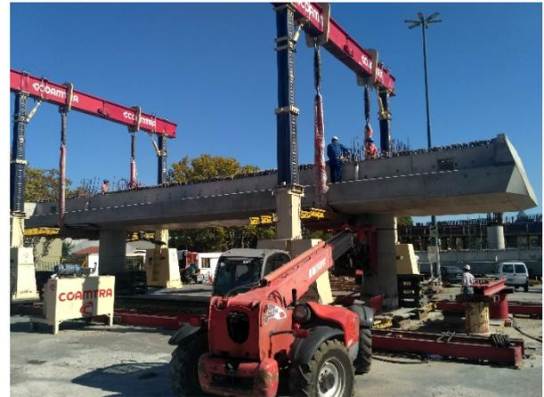
**Figura 17. Dintel prefabricado izado**
