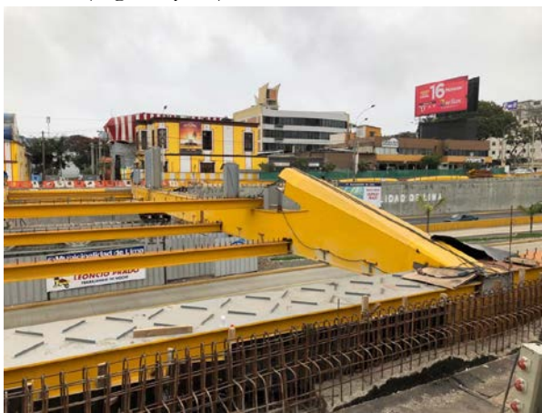
Figura 14. Montaje de la estructura metálica (Leoncio Prado).
