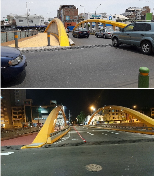
Figura 17. Ambos puentes terminados.
