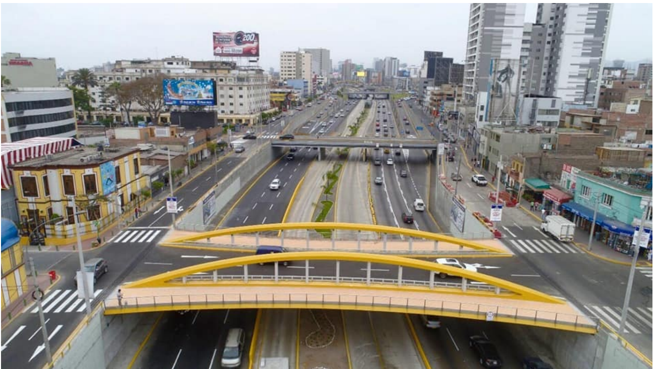
Figura 18. Puente Leoncio Prado en servicio.
