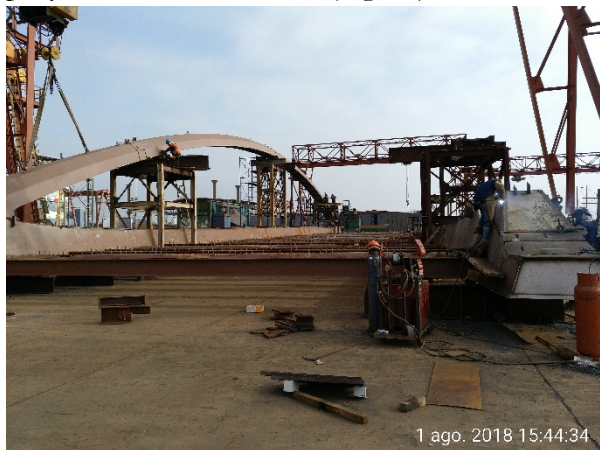
Figura 10. Montaje en taller metálico (Junín).
