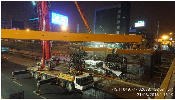
Figura 13. Izado de viga (Junín).
