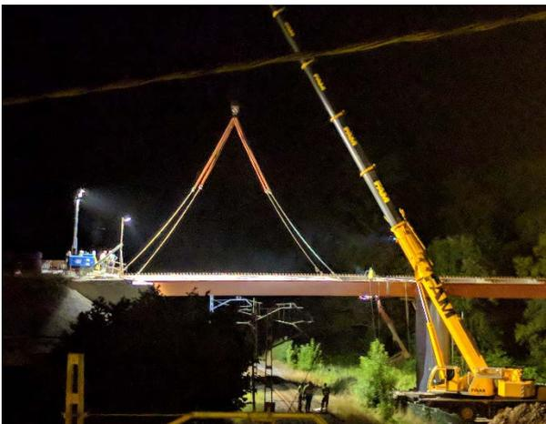
Figura 13. Montaje del tramo de estructura metálica sobre el fcc en horario nocturno.
