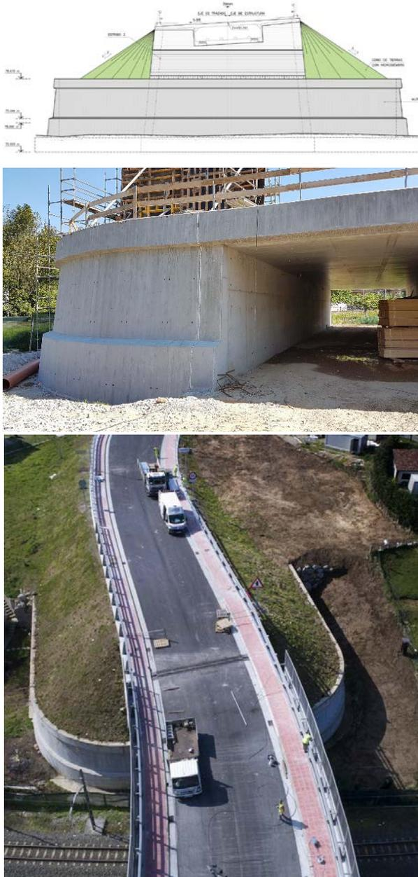
Figura 8. Plano de alzado, imagen de construcción e imagen del muro de estribo finalizado.
