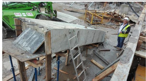
Figura 14. Plano de definición del cordón inferior y prueba de hormigonado realizada a escala real.
