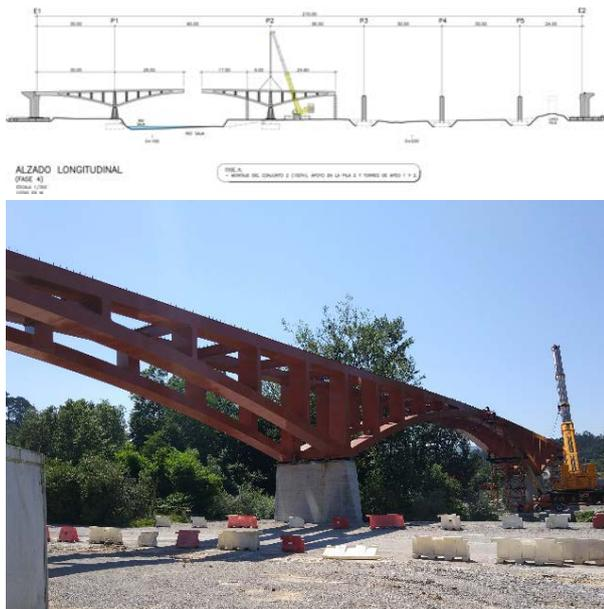
Figura 10. Montaje del segundo tramo de la estructura metálica principal.
