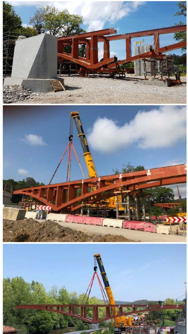
Figura 9. Montaje del primero de los “cuchillos” de la estructura metálica principal.
