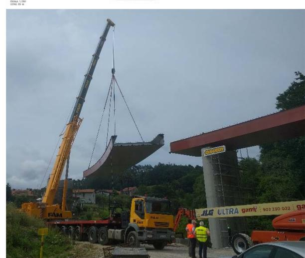
Figura 11. Montaje de varios tramos de estructura metálica del viaducto de acceso.
