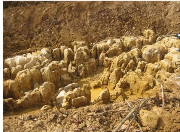
Figura 6. Afloramiento de roca caliza karstificada en área de cimentación de E1.
