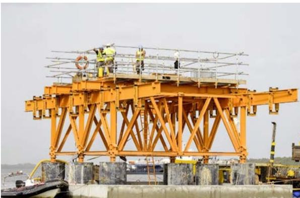
**Figura 8.** Imagen de la estructura metálica auxiliar apoyada en los pilotes interiormente rellenos de hormigón con los cajones (sacrifice formworks) ya descendidos.
