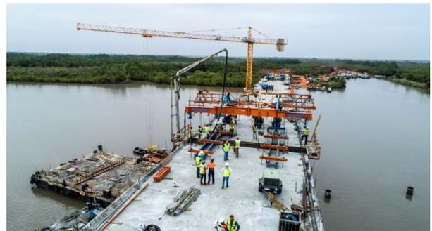
Figura 10. Ejecución de dovela de cierre de tablero.
