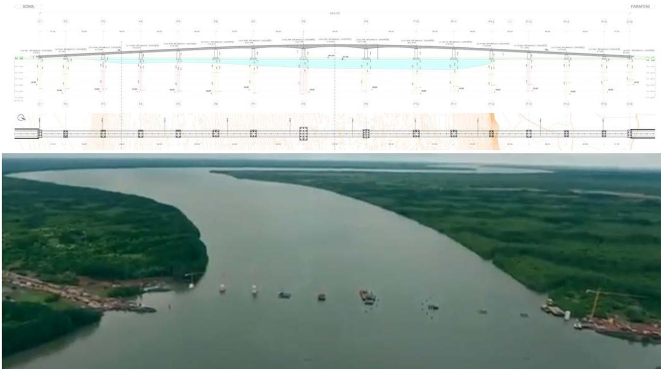
Figura 3. Alzado del viaducto principal (sup.) y vista aérea durante la ejecución de pilas (inf.).
