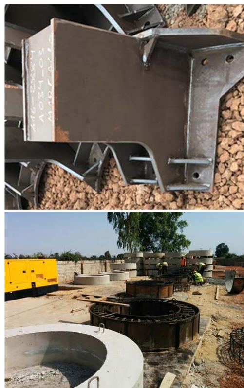
Figura 6. Imagen de las piezas de acero antes de ser sumergidas y atornilladas a los pilotes (sup.) y los donuts de hormigón para reparto de cargas (inf.).
