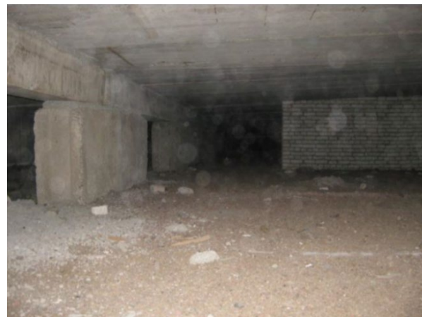
Figura 5. Vista cubierta ventilada.
