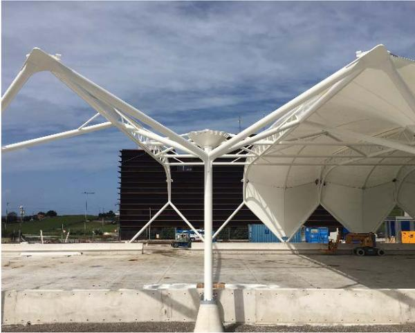
**Figura 12. Pilares metálicos de fachada sur**
