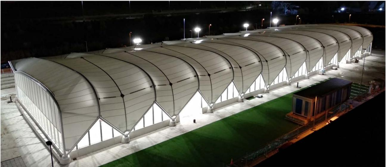
Figura 18. Vista de fachada norte. Se aprecian los cables de valle, los desviadores, y los puntos altos de tensión.
