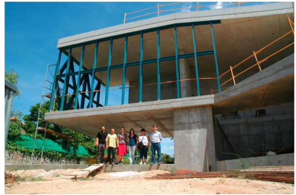
Figura 15. Vista general de la estructura del voladizo.
