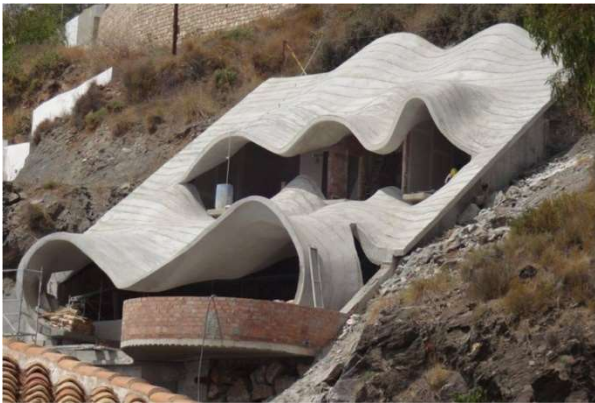
Figura 23. Estructura de hormigón de cubierta.
