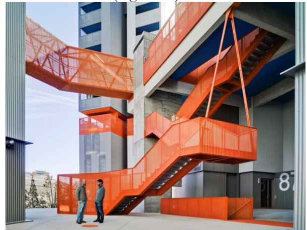
Figura 25. Escalera atirantada en edificio de 118 viviendas en Coslada.
