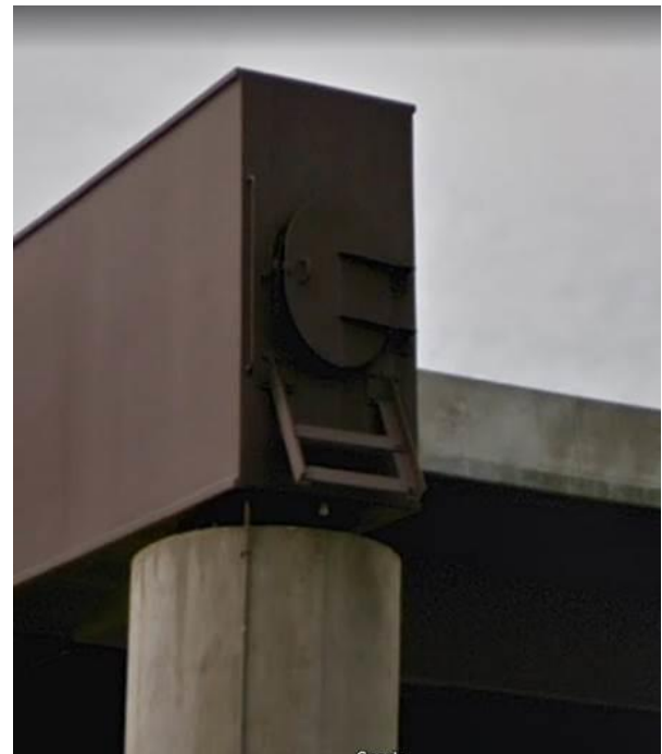
Figura 16. Detalles de la puerta de acceso de un pórtico metálico
