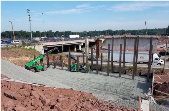
Figura 3. Construcción de pilotes sobre muro de tierra armada
