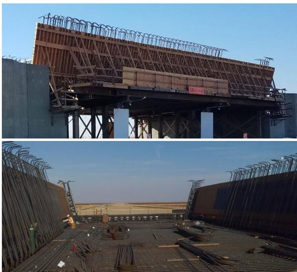
Figura 11: Fotografías de la construcción del tablero sobre *Garces Highway*
