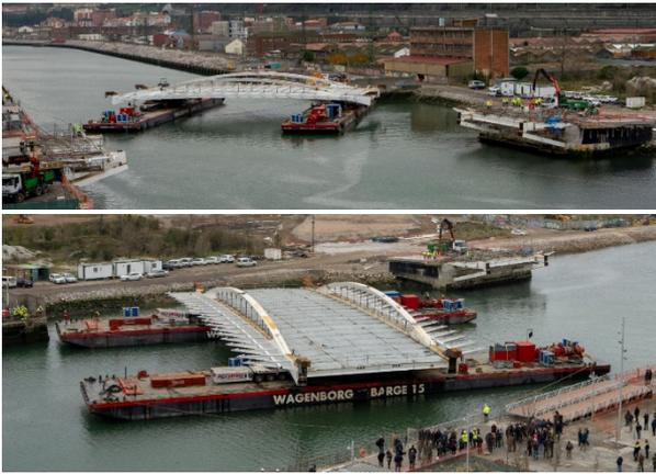
Figura 12. Traslado del bow-string por flotación
