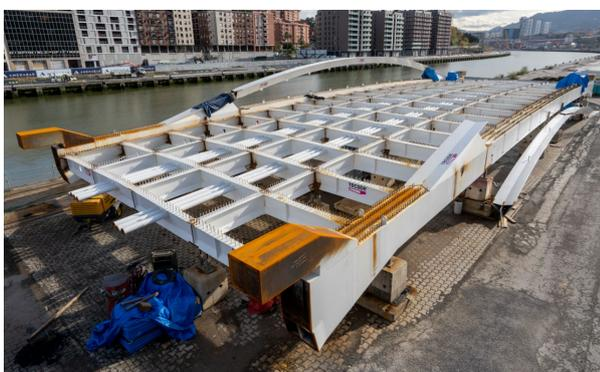
Figura 10. Ensamblaje de bow-string en campa
