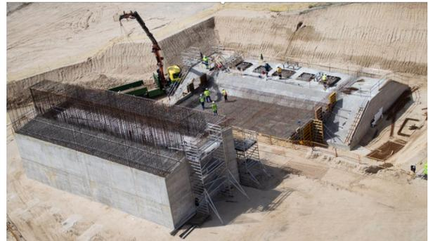
Figura 6. Cimentación de la célula triangular de empotramiento en el puente sobre la M-12.
