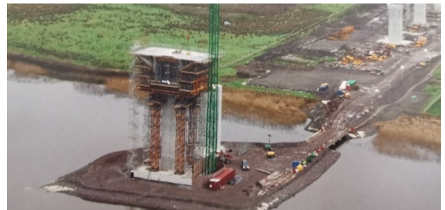
Figura 17. Dovela "0" sobre pila 4. Construida sobre cimbra
