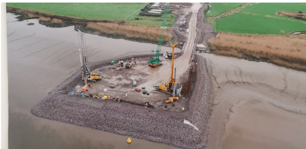
Figura 6. Península temporal para la pila central (P-4)
