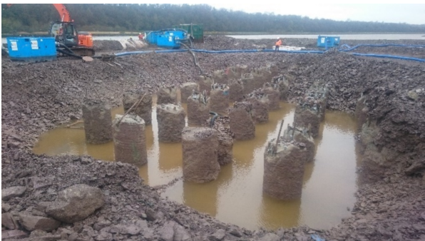
Figura 7. Pilotaje de la pila central
