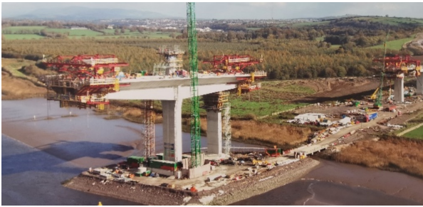
Figura 14. Voladizo en pila 4 (y Push-pull prop)
