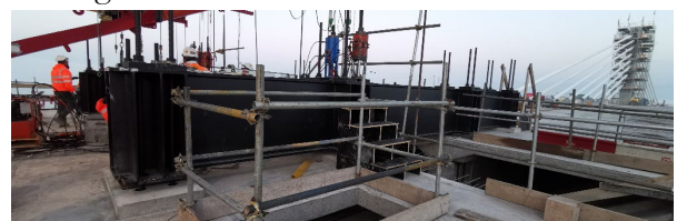
Figura 22. Vigas de bloqueo del voladizo
