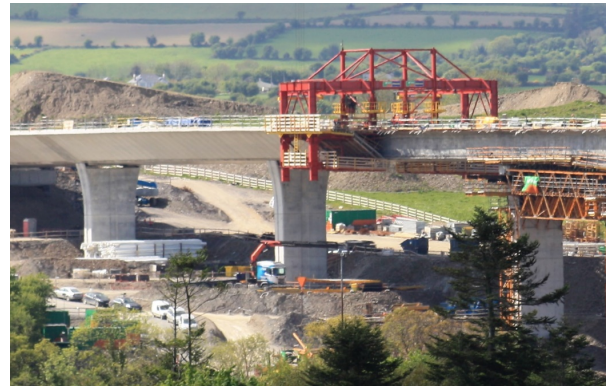
Figura 12. Carro de alas sobre vano 3
