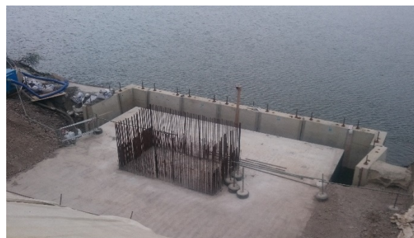
Figura 4. Cruce del río durante la construcción (P4 central -derecha- y P3 lateral -izquierda-)
