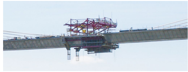
Figura 21. Flecha diferencial en voladizo de vano 4
