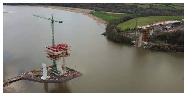
Figura 1. Cruce del río durante la construcción (P4 central -derecha- y P3 lateral -izquierda-)
