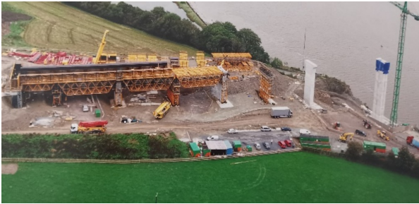
Figura 10. Tramo de cimbra sobre el vano 1 y 2
