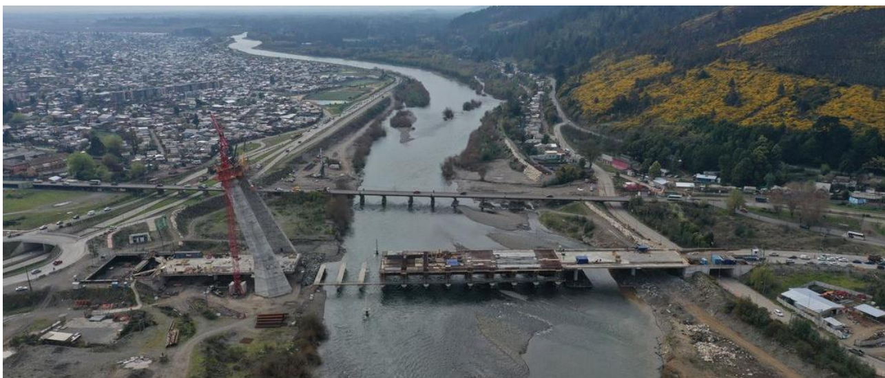
Figura 2. Vista general del avance de los trabajos de construcción del puente.
