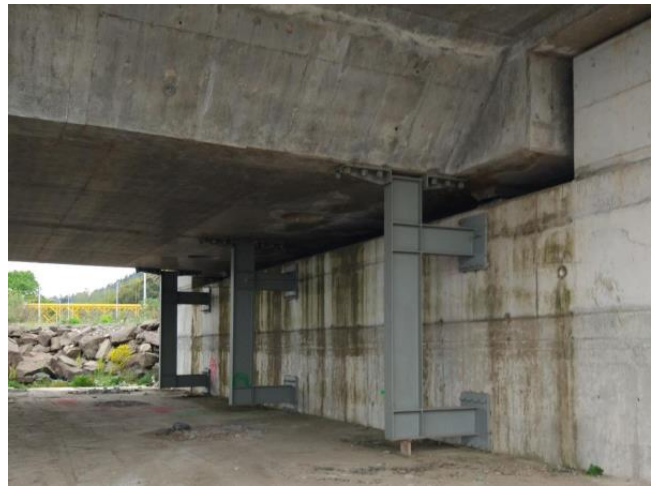
Figura 14. Sistema de bloqueo sísmico temporal: tope transversal (izq.) y longitudinal (der.)
