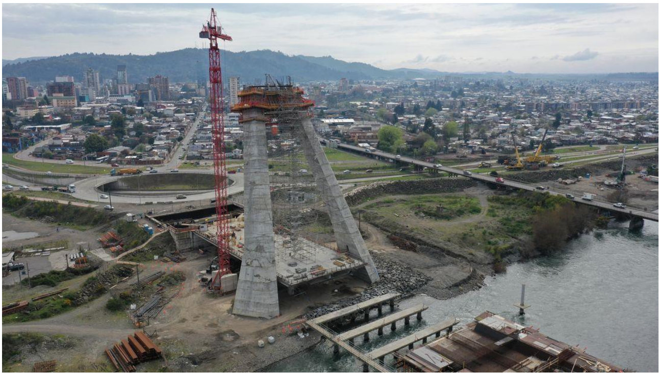
Figura 4. Estado actual de la construcción del mástil.
