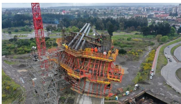
Figura 20. Trabajos de ferrallado en la cabeza del mástil.
