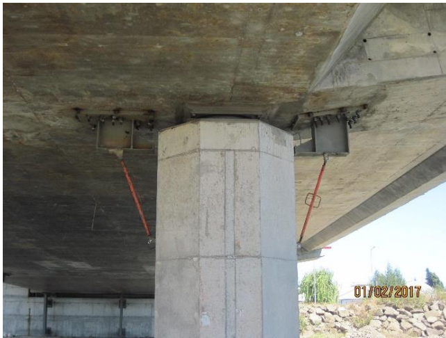
Figura 14. Sistema de bloqueo sísmico temporal: tope transversal (izq.) y longitudinal (der.)
