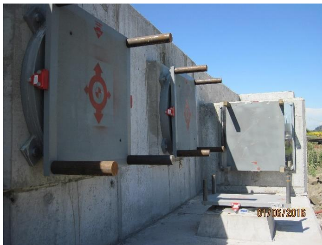
Figura 13. Topes sísmicos longitudinales (izq.) y tope sísmico transversal (der.) en estribo EP.
