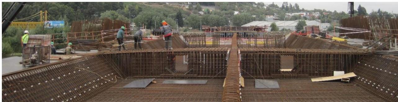
Figura 12. Armadura de refuerzo en las almas del tablero.
