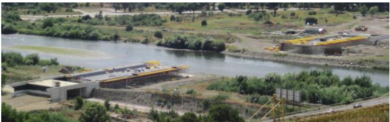
Figura 9. Construcción, sobre cimbra cuajada, de los vanos laterales del puente.
