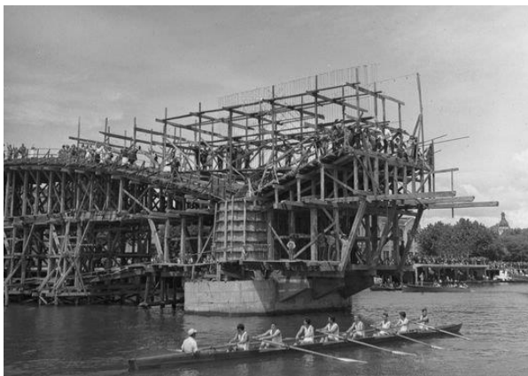
Figura 1. Puente durante la construcción.
