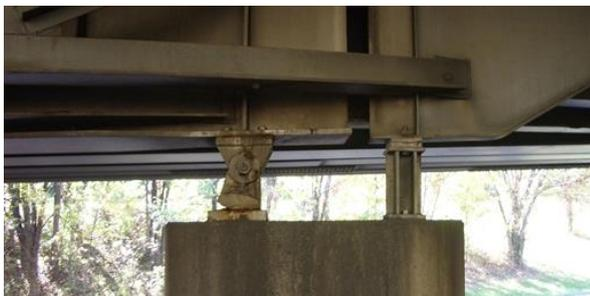
Figura 2. Apoyos puente existente.
