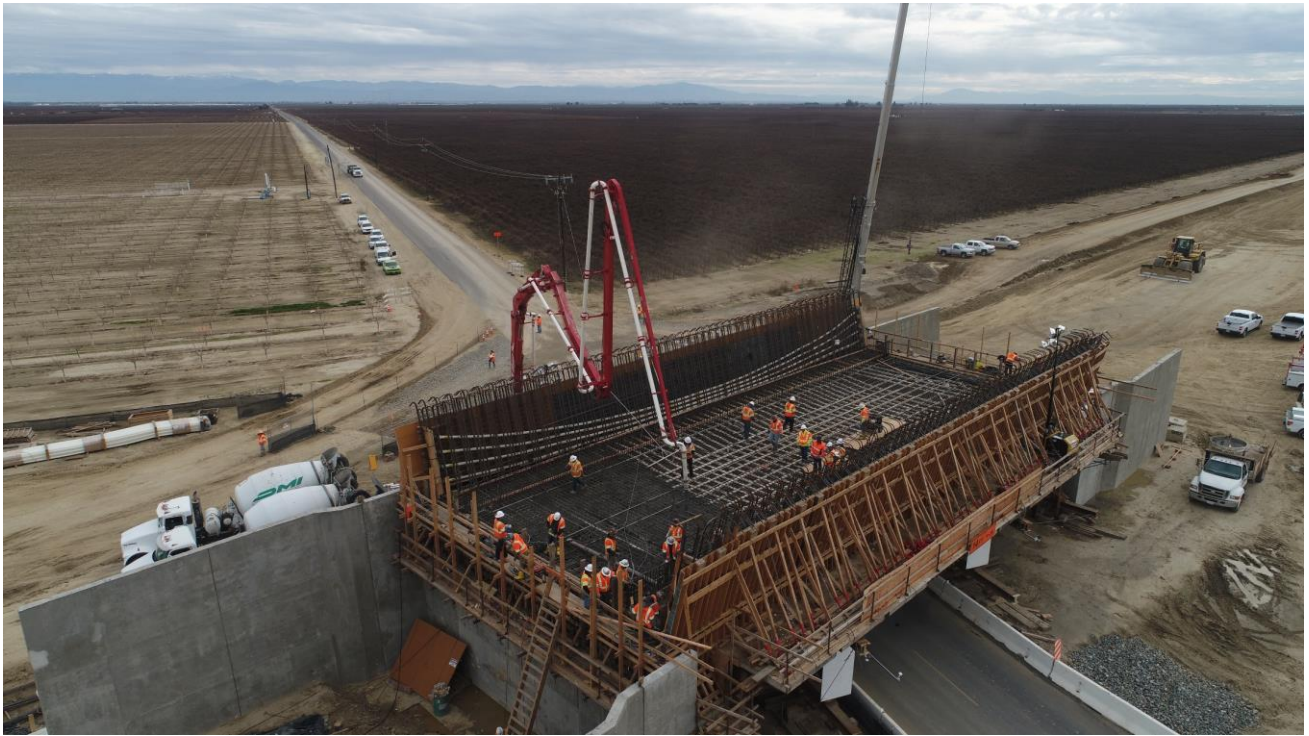
Figura 15. Trabajos de hormigonado de la losa inferior del tablero del puente isostático de un vano.
