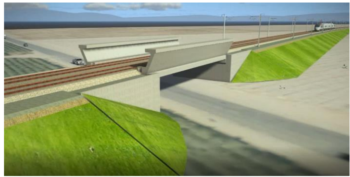
Figura 14. Infografía del puente isostático de un vano.
