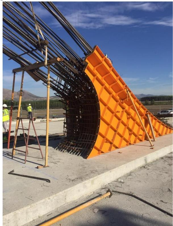
Figura 11. Encofrado metálico para hormigonado de arranque de arcos
