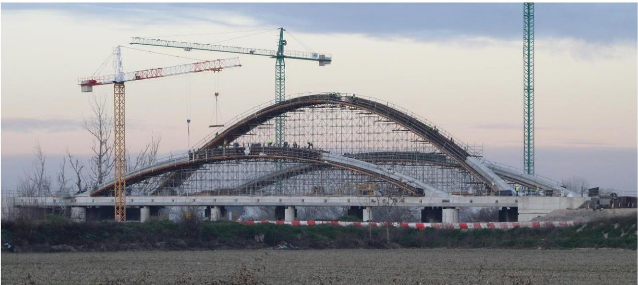
Figura 3. Vista del puente en el momento de hormigonado de los arcos
