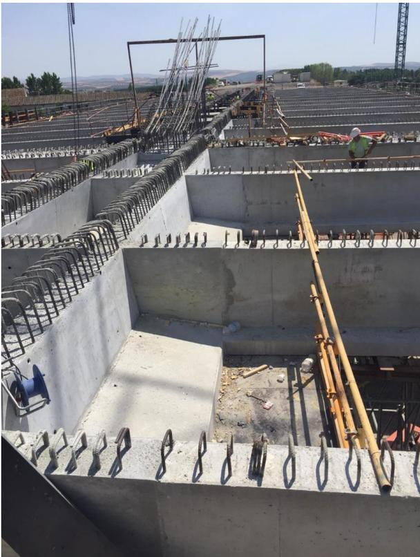
Figura 8. Hormigonado de viga tirante central
