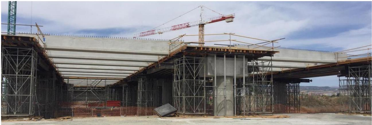
Figura 6. Colocación de nervios transversales prefabricados
