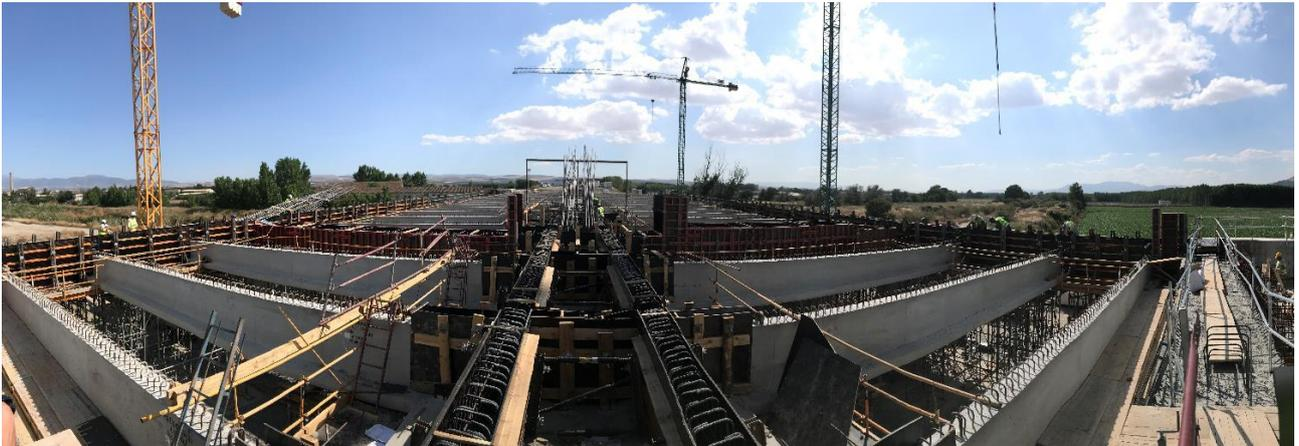
Figura 7. Ferrallado de vigas tirante longitudinales para hormigonado in situ
