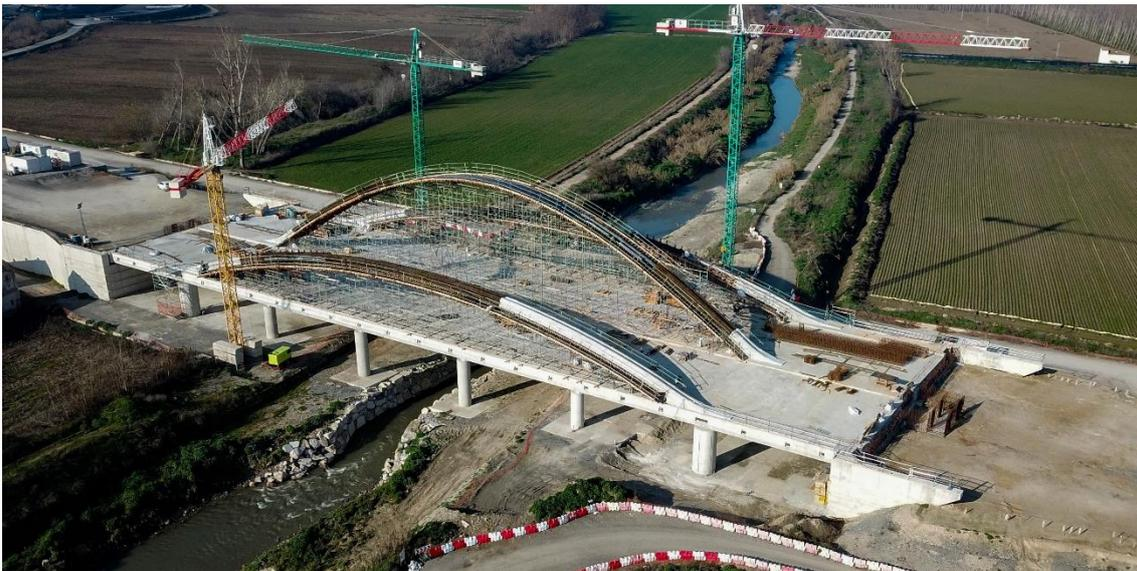
Figura 15. Vista aérea del estado del puente durante el hormigonado de arcos
