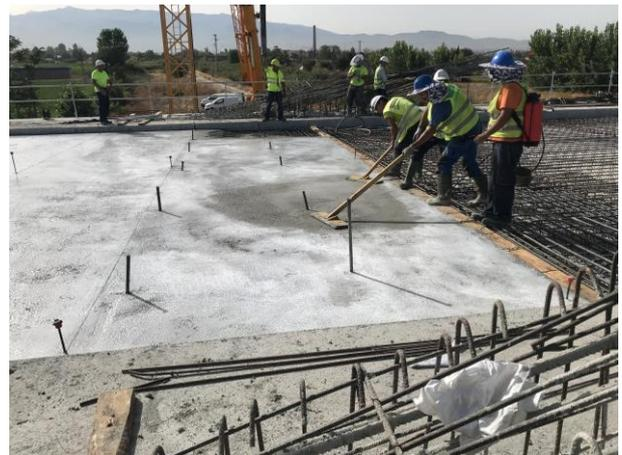
Figura 9. Hormigonado de la losa del tablero
