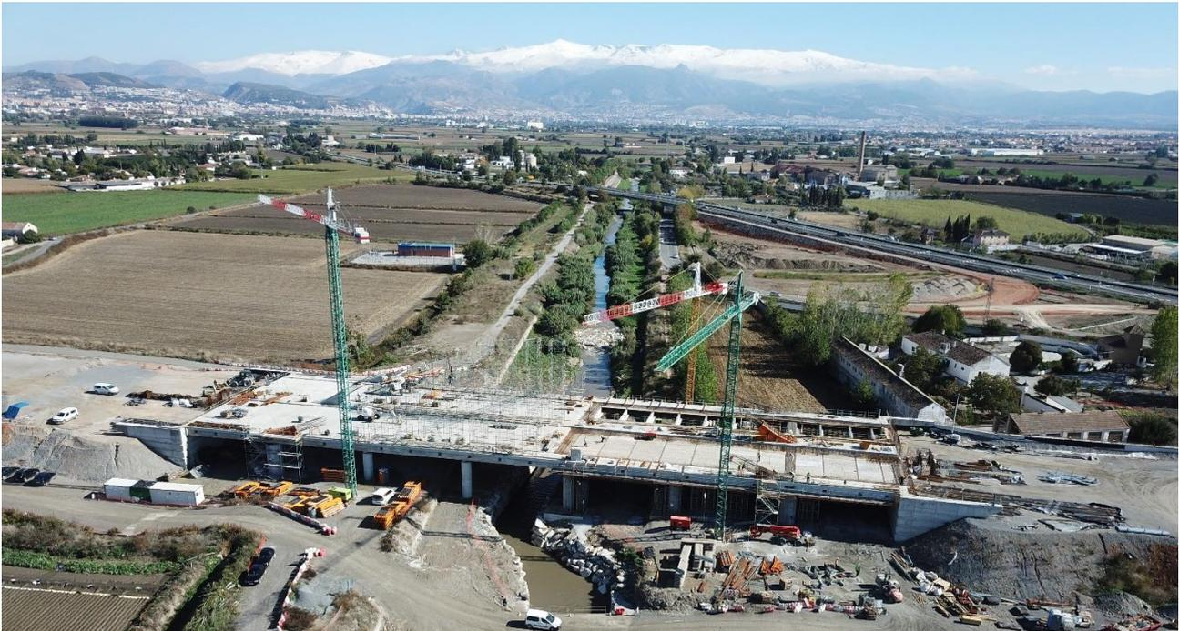
Figura 10. Finalización del hormigonado y descimbrado del
