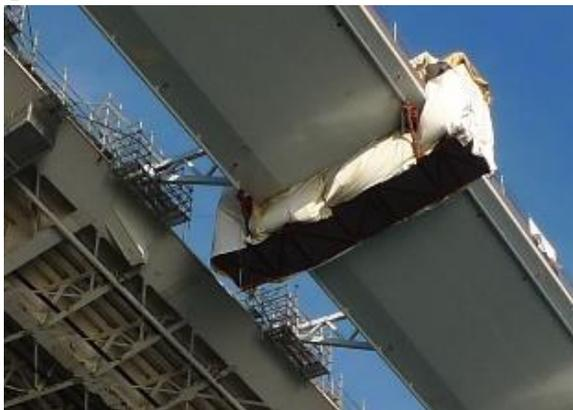
**Figura 22.** Línea de izado del carro inferior y balancín de ajuste de la pendiente transversal de la dovela.
