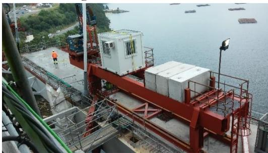
Figura 18. Carro de izado superior.
