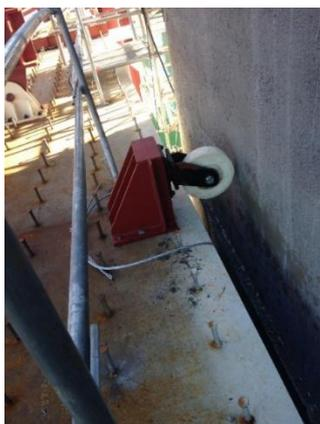
**Figura 15.** Rueda para deslizamiento de la dovela 07 sobre la cara lateral del fuste.
