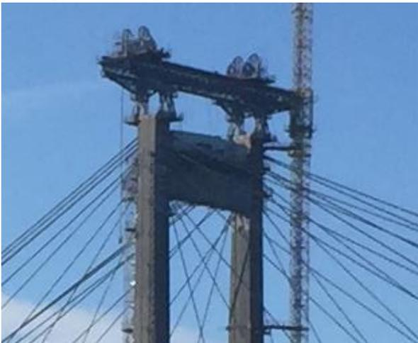
**Figura 8. Pórtico de izado sobre la pila principal.**
