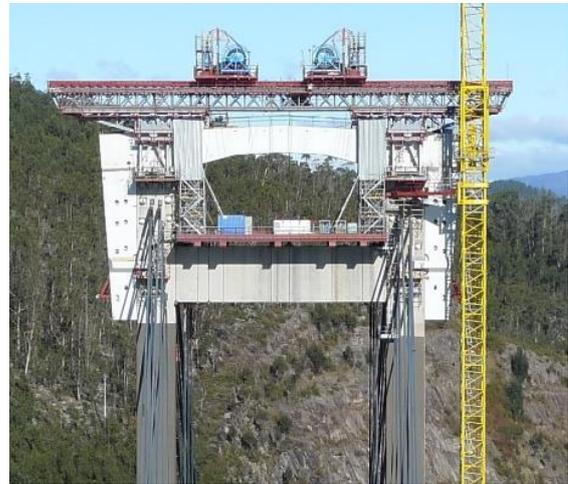
Figura 13. Izado y soldadura del dintel del cabecero.
