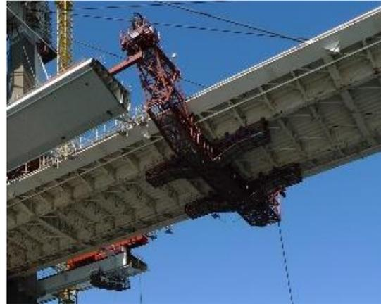
Figura 19. Carro de izado inferior.
