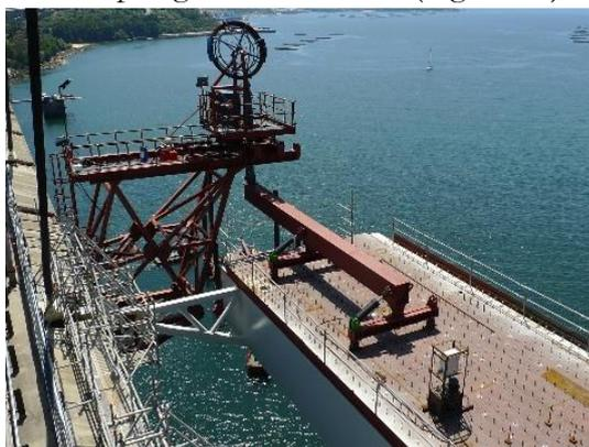
**Figura 21.** Línea de izado del carro inferior y balancín de ajuste de la pendiente transversal de la dovela.
