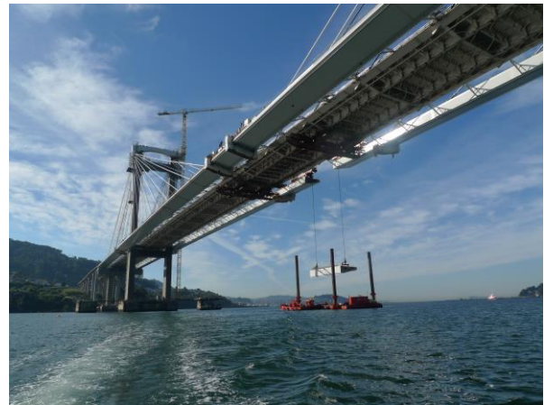
Figura 1. Vista inferior de los tableros.
