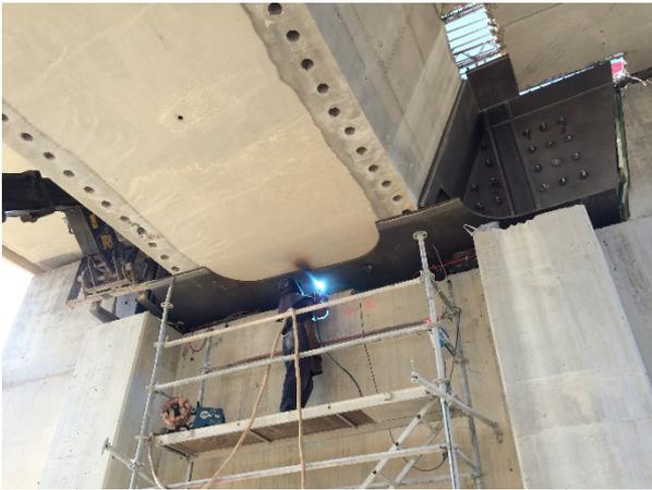
**Figura 11. Montaje de dovelas de estribo y ejecución de soldadura de conexión in situ**
