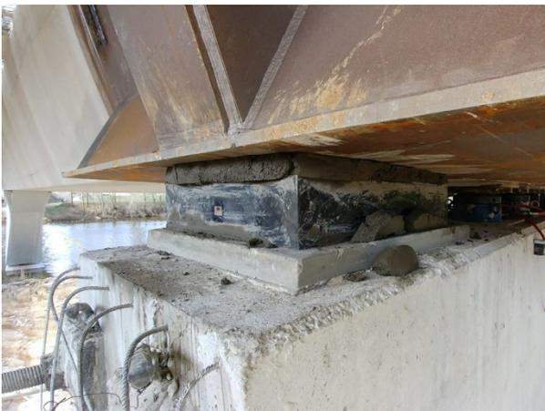
**Figura 12. Descenso del tablero sobre los nuevos aparatos de apoyo.**
