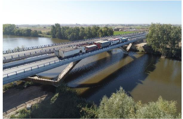
Figura 23. Prueba de carga.
