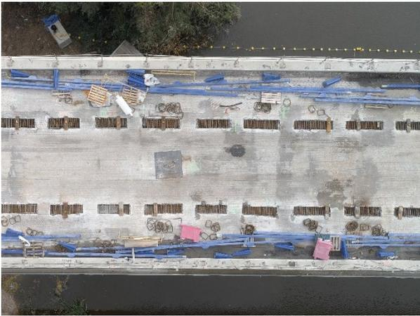
**Figura 14. Vista en planta de la estructura con las ventanas ejecutadas en los voladizos para alojar los pernos conectadores de la platabanda superior.**
