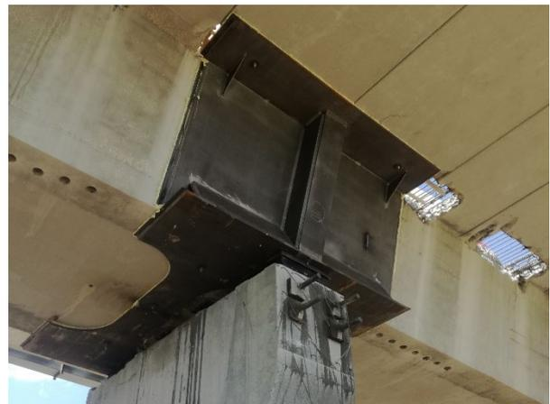
**Figura 10. Montaje de dovelas de pila.**
