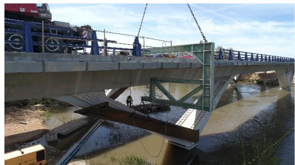
Figura 20. *Montaje del forro metálico en pilas en V.*
