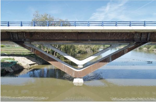
Figura 22. Vista final de las pilas en V.
