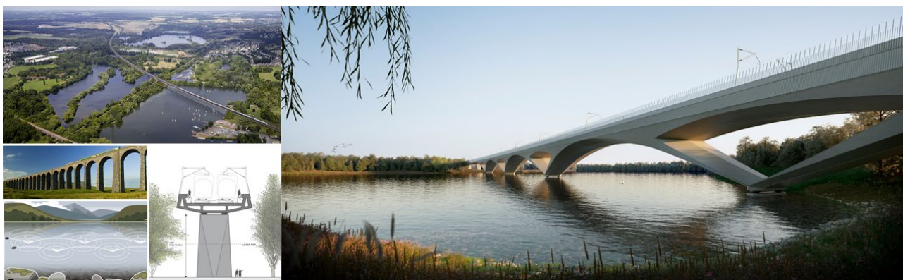
Figura 7. Viaducto del Valle del Colne. Contexto, referencias, sección tipo y pilas en zonas boscosas y cruce sobre lagos principales con un esquema de viga multivano con muchas de las propiedades formales de un puente arco
