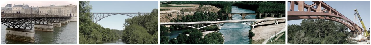
Figura 5. Celosías (trianguladas o Vierendeel) que, para muchos parecen arcos
