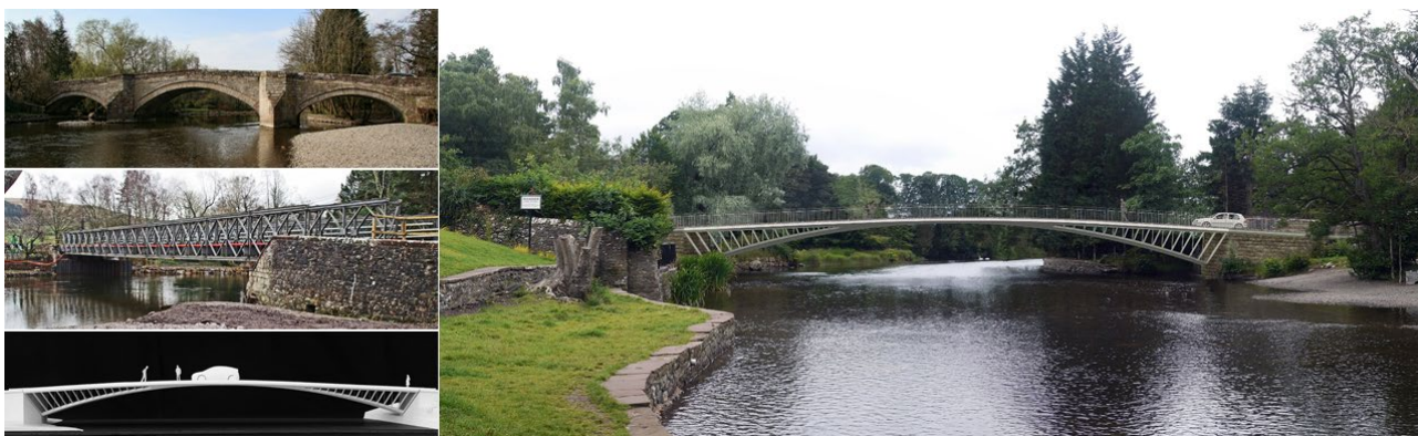
Figura 8. Nuevo Puente en Pooley Bridge. Puente de piedra, puente temporal, modelo físico del nuevo puente e integración en su entorno, respetando un paisaje único y al puente histórico que lo precedió
