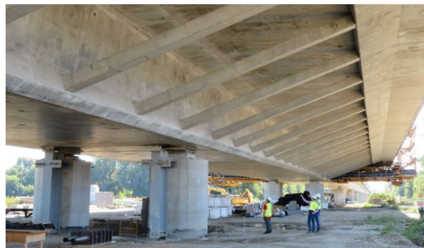
Figura 10. Vista inferior del tablero
