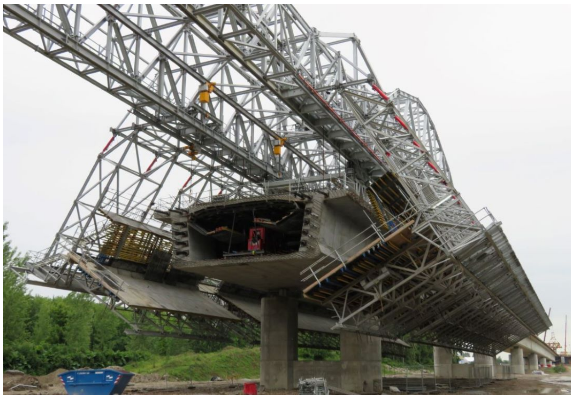
Figura 8. Vista general durante la construcción, en el momento de desencofrado de una fase de cajón central.
