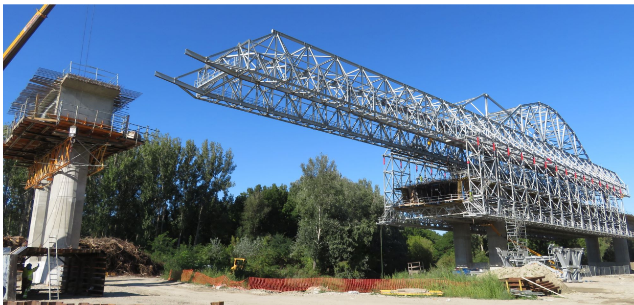
Figura 6. Vista general de la autocimbra sobre el tablero. A la izquierda se observa una dovela 0 sobre pila.
