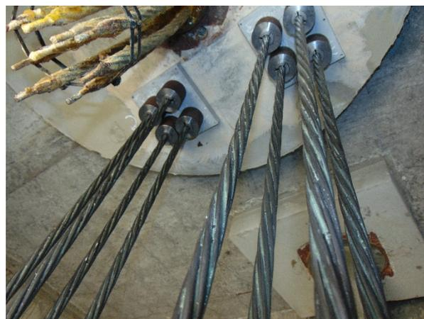
**Figura 7. Vista desde debajo de la losa de anclaje de los nuevos cordones, barriletes y placas de reparto**
