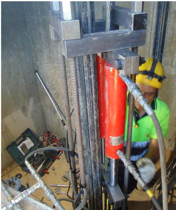
**Figura 15. Dispositivo de destesado. Técnico comprobando que se había eliminado la tensión**
