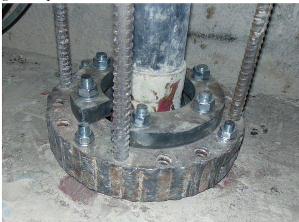
**Figura 17. Imagen del pedestal anclado a losa mediante anclajes químicos**
