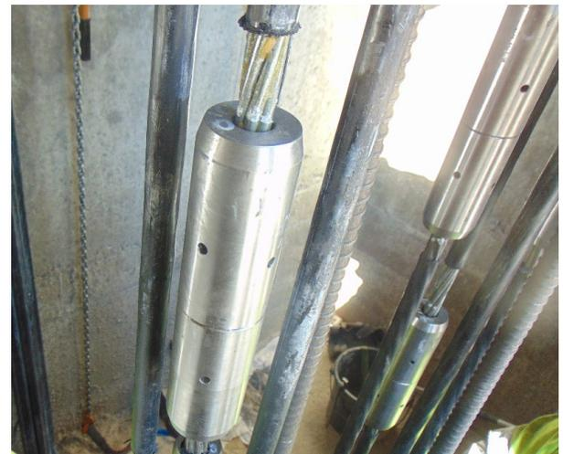
Figura 12 y 13. Manguitos de empalme de tramos de cordón 0,6' (original) y 0,62" (nuevo)
