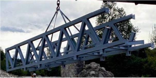
**Figura 12. Tramo de estructura metálica**
