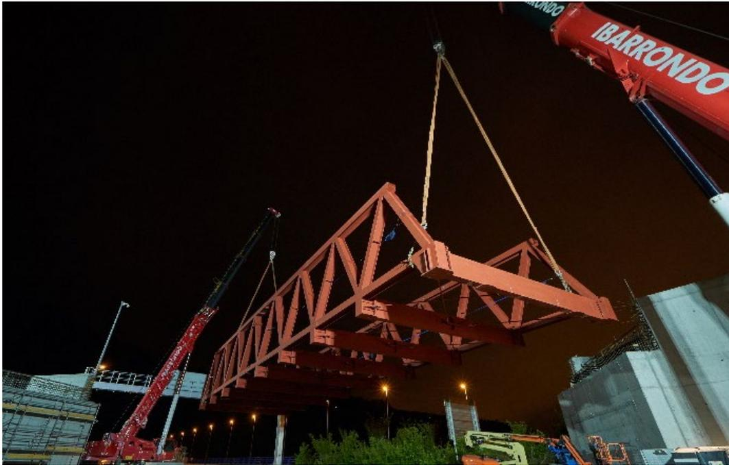
Figura 3. Izado de la estructura para su colocación
