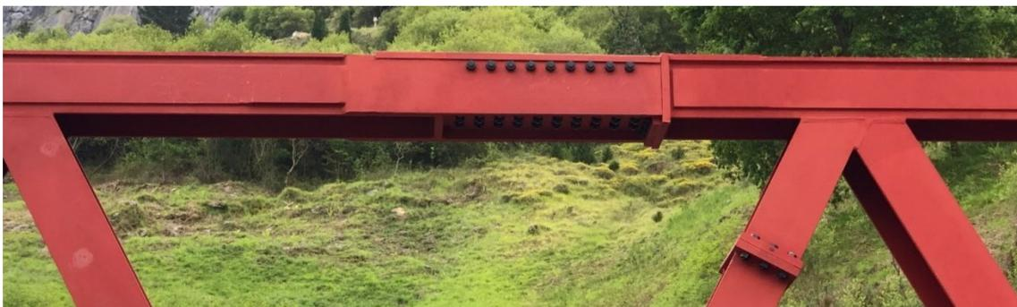
Figura 6. Unión longitudinal de los cordones
