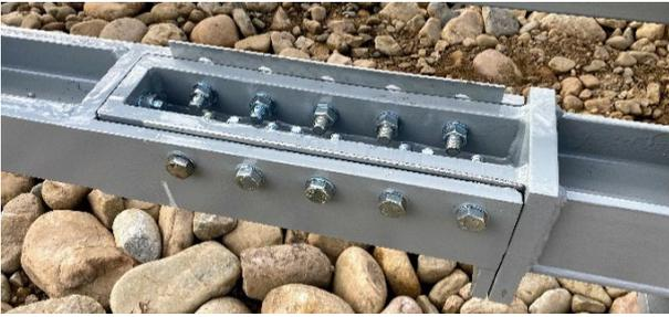
**Figura 13. Unión machihembrada**
