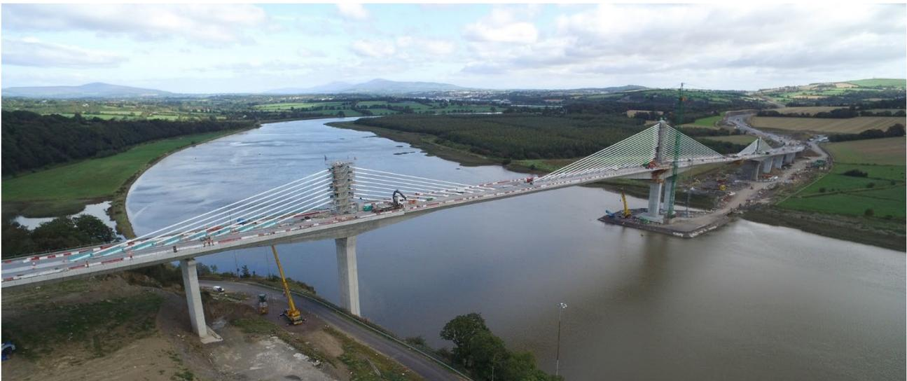
Figura 18: vista aérea del puente casi terminado, desde el lado Oeste, vano principal sobre el río.
