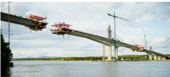
Figura 2: vista de la construcción, desde el lado Oeste (carros de avance en voladizo).
