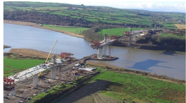
Figura 3: vista de la construcción, desde el lado Oeste (carros de avance en voladizo).
