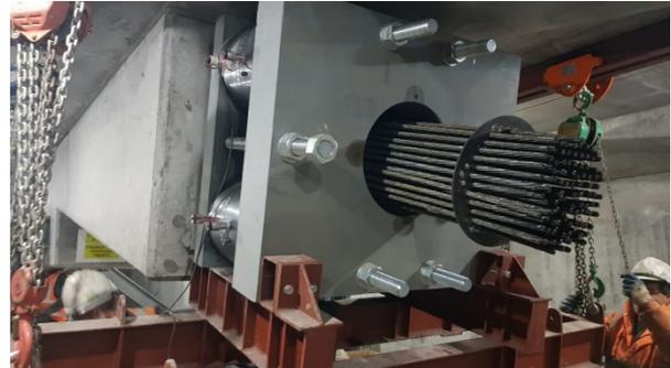
Figura 17: retesado de tirantes actuando sobre el anclaje, con conjunto de 4 gatos grandes.
