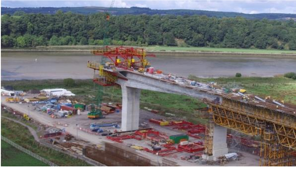
La división en dovelas fue la siguiente: 4 dovelas de 4.5 m, que arrancaban a 6 m desde el eje de pila (el equivalente a la semi-dimensión de la dovela cero), en zona de canto variable sin tirantes, y ya en la zona de canto constante 8 dovelas de 6.50 m, a las que le corresponde tirante. Finalmente una dovela de 5.00 m antes de la de cierre, ya sin tirante, lo que hace un total de 13 dovelas para una longitud desde eje de pila de 81 m (82.50 al centro de la dovela de cierre).
