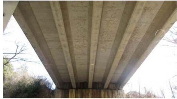
Figura 5. Puente de vigas con aparente buen estado de conservación.
