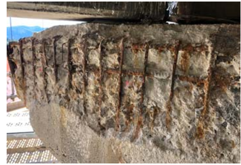
Figura 13. Saneado de hormigón deteriorado en cabeza de pila.
