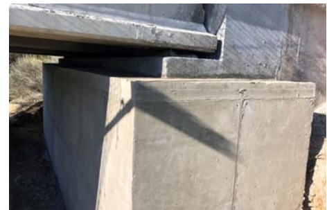
Figura 14. Vista general de estribo recrecido finalizado.
