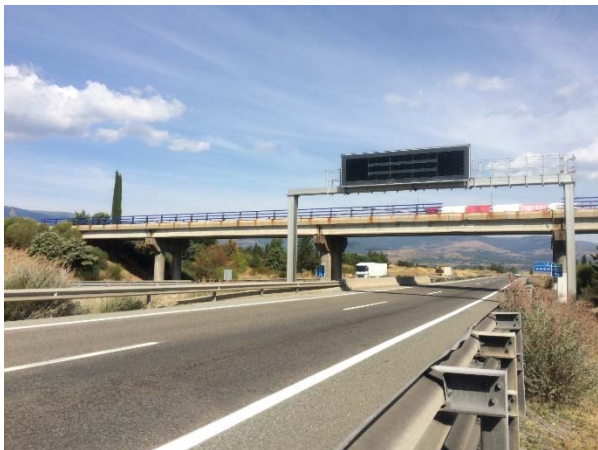
Figura 8. Vista general de uno de los pasos superiores afectados.
