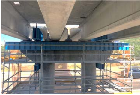
Figura 15. Sistema de apeo de tablero mediante cuelgue de pila a través de entramado metálico.
