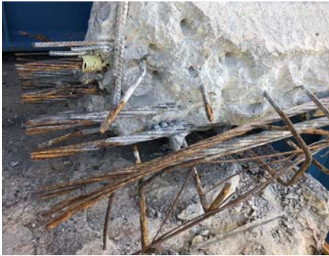
Figura 16. Saneado de culatas de vigas tras apeo de estructura.
