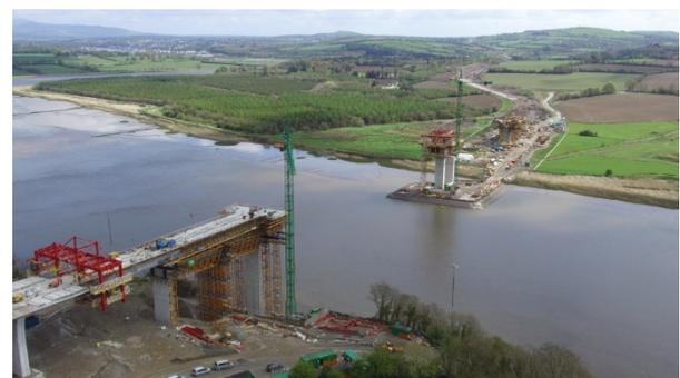
Figura 2: vista aérea de la construcción, desde el lado oeste (carro de alas y cimbra en vano 3).
