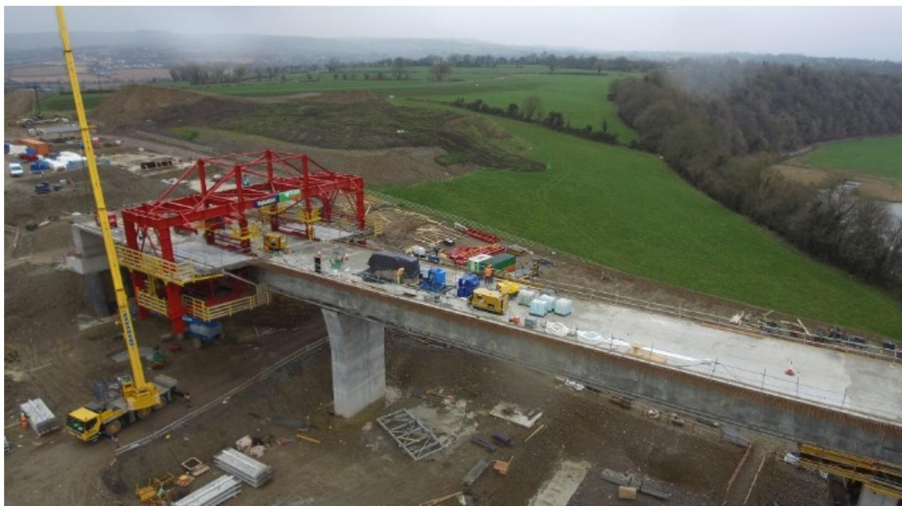
Figura 17: vista aérea del carro de alas en una de las primeras puestas del lado oeste.
