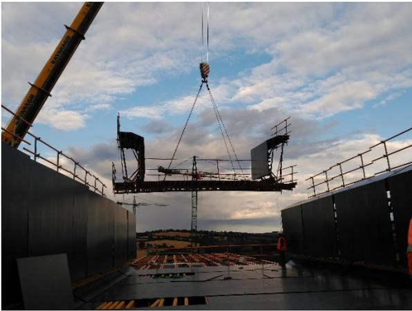
Figura 13: montaje de los barcos de encofrado.
