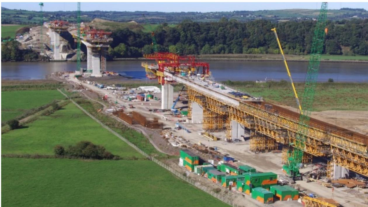
Figura 3: vista aérea de la construcción, desde el lado este (carro de alas en vano 6, cimbra en vanos 6, 7 y 8).
