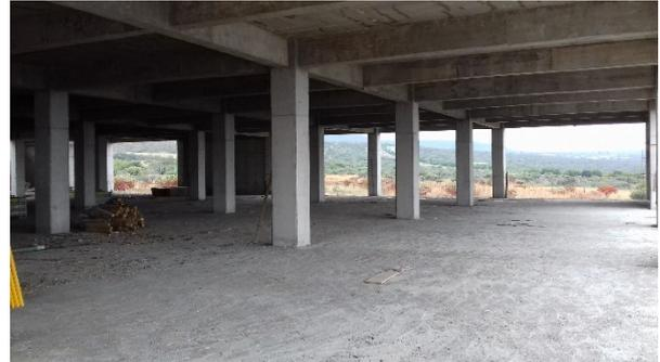
Figura 18. Vista inferior de forjados. Trabes principales, secundarias y losa de piso.
