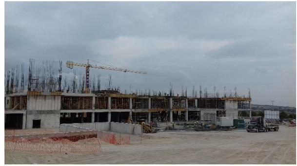
Figura 17. Vista del avance de estructura. Muros de Cortante y marcos.
