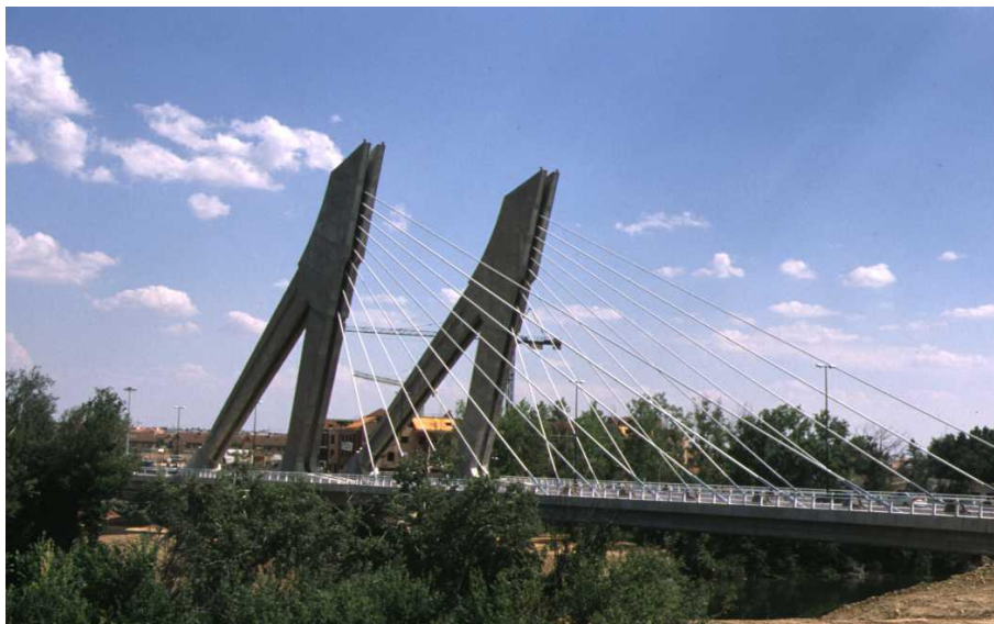
Figura 2. Puente de Hispanoamérica sobre el río Pisuerga en Valladolid
