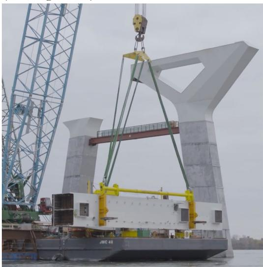
Figura 13. Arriostramiento provisional de pilas
