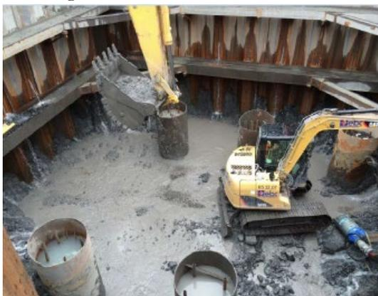
Para las cimentaciones en tierra se ejecutaron recintos tablestacados en los que se trabajaba después, excavando interiormente hasta la cota necesaria (ver figura 8). En ellos se ejecutaban bien cimentaciones directas, como es el caso de las pilas W27 a W22 o las pilas E02 a E06, o bien profundas, como sucedió en las pilas E07 a E10.
