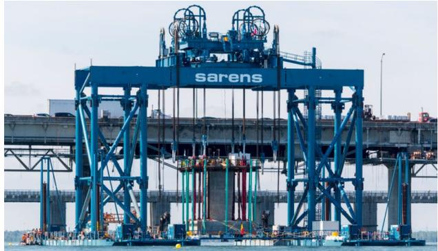
Figura 9. Izado, transporte y colocación de zapatas.
