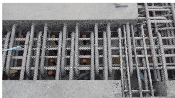
**Figura 20. Detalle de la junta entre losas prefabricadas**
