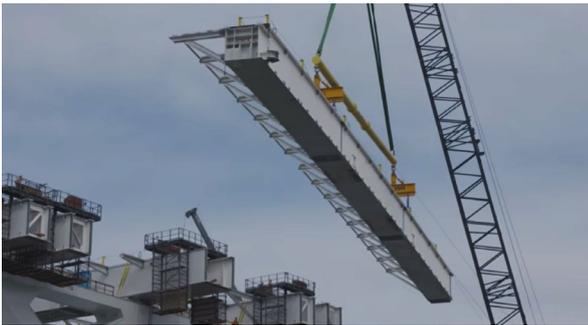
Figura 17. Montaje de semisección de uno de los tableros laterales
