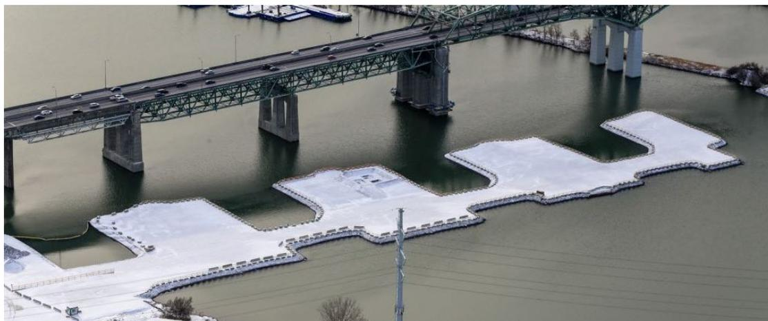
En cuanto a las pilas, en los viaductos de acceso tenemos dos tipos de ejecución para sus cimentaciones. Por un lado, tenemos cimentaciones ejecutadas en tierra, que corresponden a las 9 pilas del viaducto Este y a otras 7 pilas en el Oeste (de W27 a W22 y W02, que queda dentro del pantalán usado para ejecutar el tramo de compensación del tramo atirantado) y por otro lado, tenemos las otras 18 pilas del viaducto Oeste (de W21 a W03), que se ejecutaban en el río.
