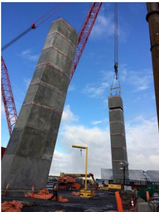
Figura 12. Montaje de dovelas de pila prefabricadas
