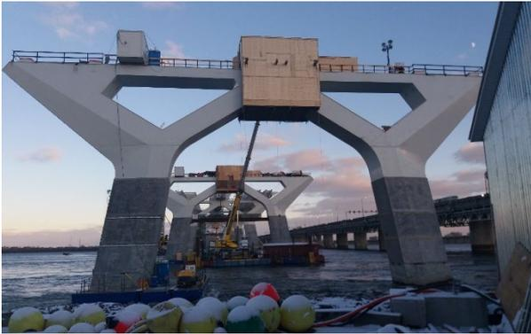
Figura 15. Conexión entre mitades del dintel
