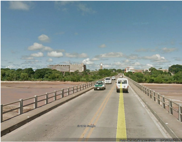
Figura 1. Vista del puente Foianini, único puente existente en la actualidad para el cruce del río Pirai en Santa Cruz de la Sierra.
