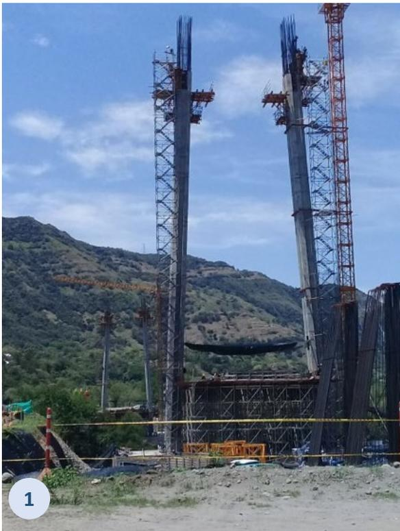
Figura 11. Construcción Dovela sobre pila
