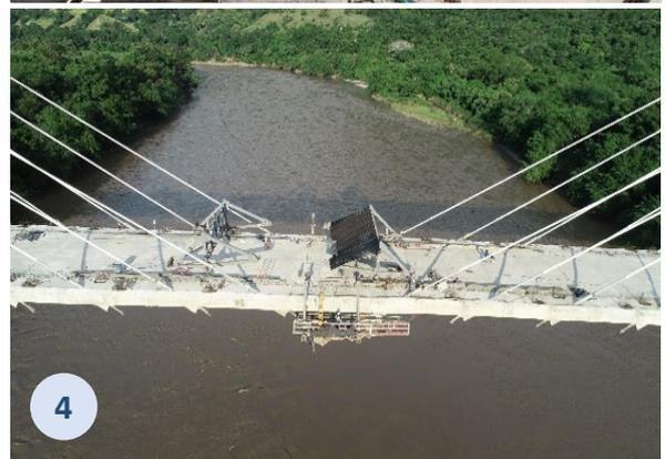
**Figura 14. Construcción dovela de cierre vano principal**
