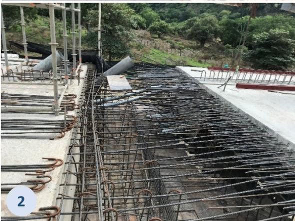
Figura 12. Construcción dovela de cierre con contrapeso Puerto Bogotá
