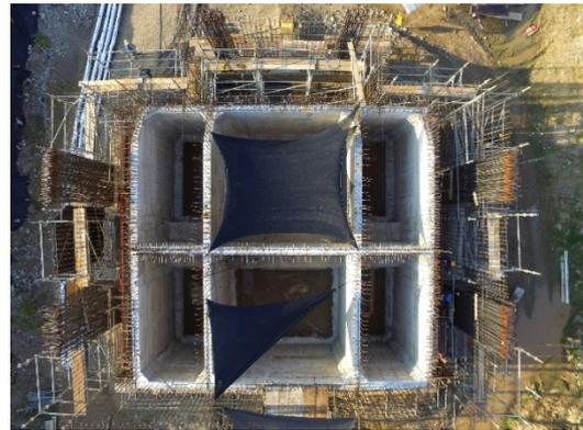
Figura 7. Construcción contrapeso. Bóvedas para relleno. Puerto Bogotá
