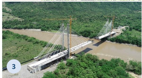
Figura 13. Construcción tablero con carros de avance. Después de cierre con contrapeso
