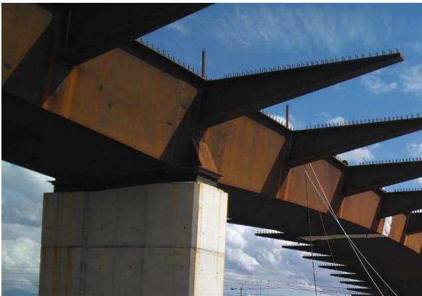
Figura 5. Vista exterior del mamparo de pila 1.
