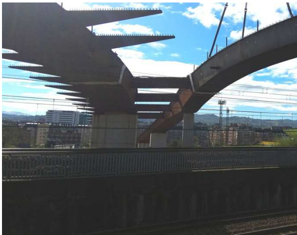
Figura 9. Vista de las riostras entre cajones metálicos.
