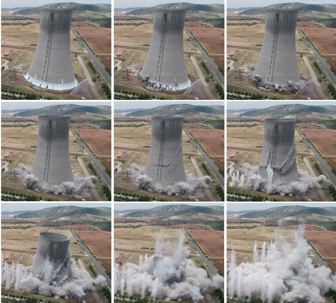
Figura 16. Fotografías del proceso de caída de la Torre de Refrigeración.
