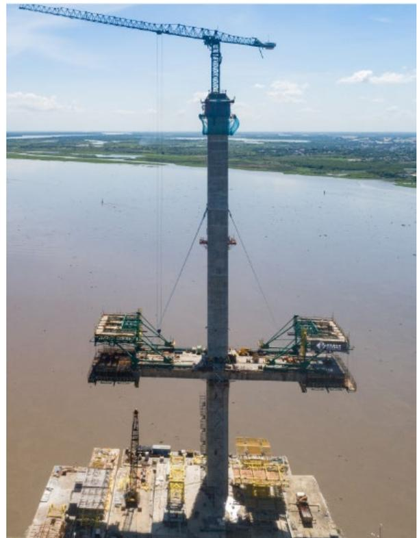
Figura 12. Pilono 13 tras eliminación del sistema de fijación provisional
