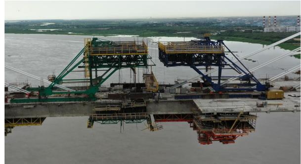
**Figura 8. Vigas de continuidad en cierre vano principal**
