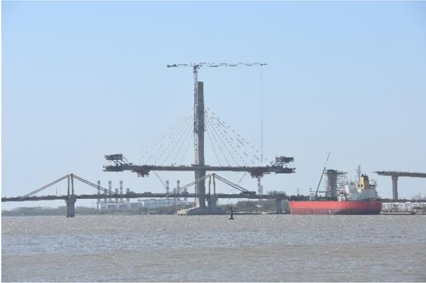
Figura 3. Carro de avance y carro de alas pilono 14
