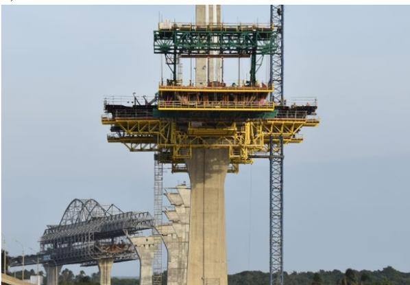
Figura 4. Carro de avance y carro de alas pilono 13
