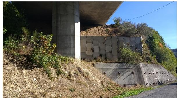
Figura 2. Estribo E-1 del viaducto de Noceda I.
