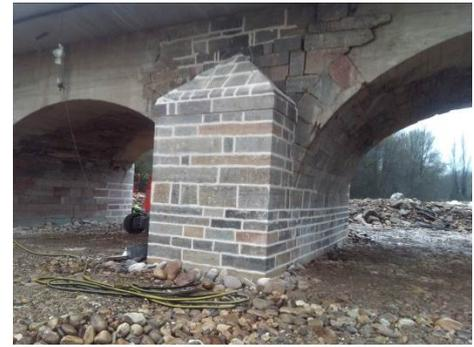
**Figura 24. Vista general de pila tipo tras la actuación de limpieza, reparación y rejuntado de llagas.**
