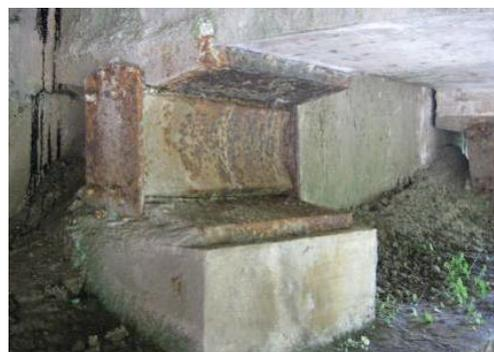
Figura 7. Detalle de apoyo sobre pila-estribo de tipo "biela"
