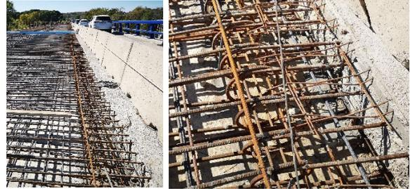
**Figura 23. Detalle solape en lazo de armadura transversal entre fases de hormigonado**
