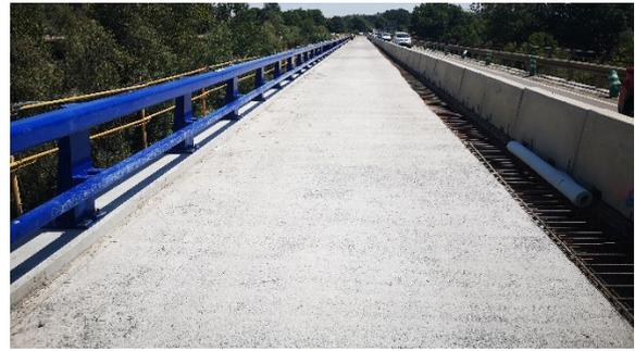
**Figura 22. Detalle de semilosa construida, con el sistema de contención implantado**
