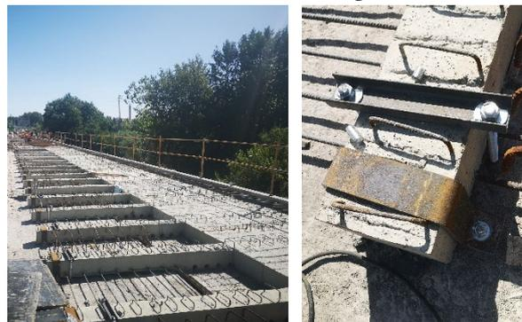
Figura 19. Instalación en obra de prelasas
