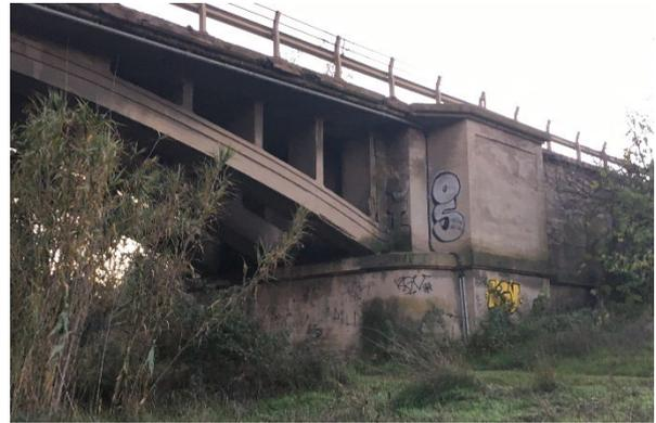
Las pilas son de hormigón en masa, de planta rectangular y con sendas áreas adosadas semicirculares aguas arriba y abajo respectivamente, que se elevaban formando troncos de cono, proporcionando un perfil hidrodinámico. Sobre estas pilas se disponen unas tabicas rectangulares de separación entre arcos.
