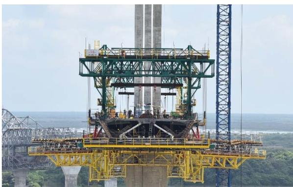
Figura 19. Vista frontal de los carros de avance (superior) y de alas (inferior)
