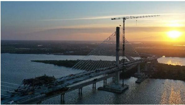
Figura 5. Disposición de tirantes en el pilono P13
