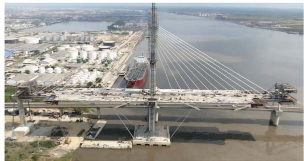
Figura 20. Vista aérea del pilono P14 en la que se aprecian los cables de arriostamiento inferiores
