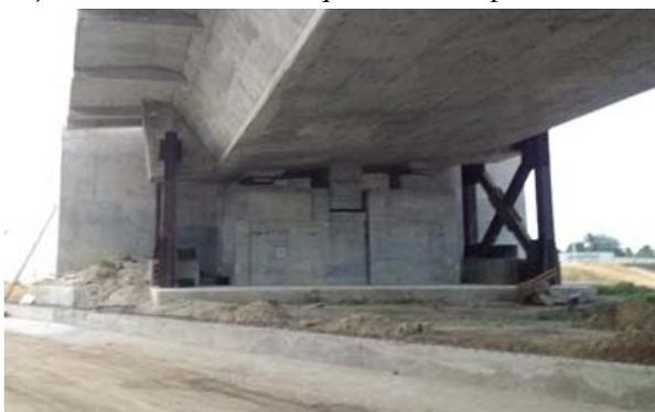
**Figura 16. Puntos fijos provisionales en fase constructiva**
